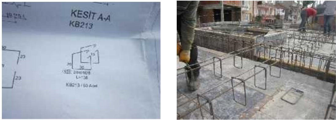
Şekil 4.23. Dişli döşemelerde enine dişlerin en kesit boyutları ile ilgili şartlara uyulmaması durumu
