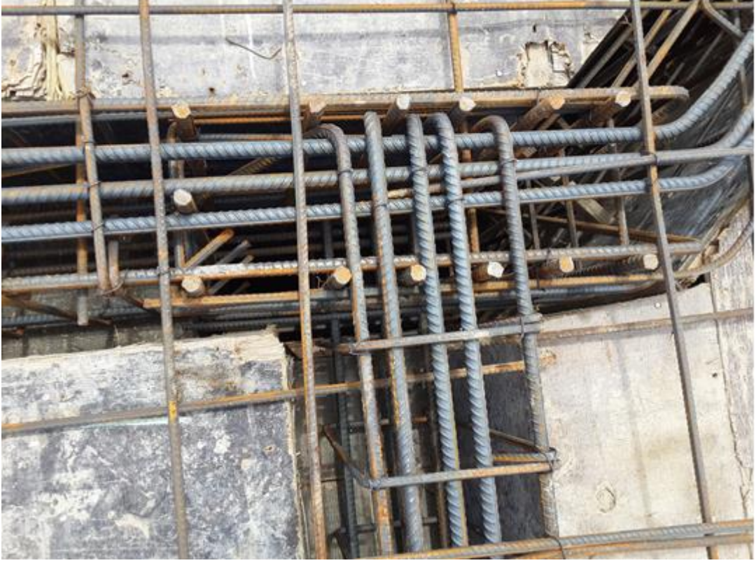
Şekil 4.12. Kirişlerde boyuna donatı çubukları arasındaki mesafe şartına uyumaması
