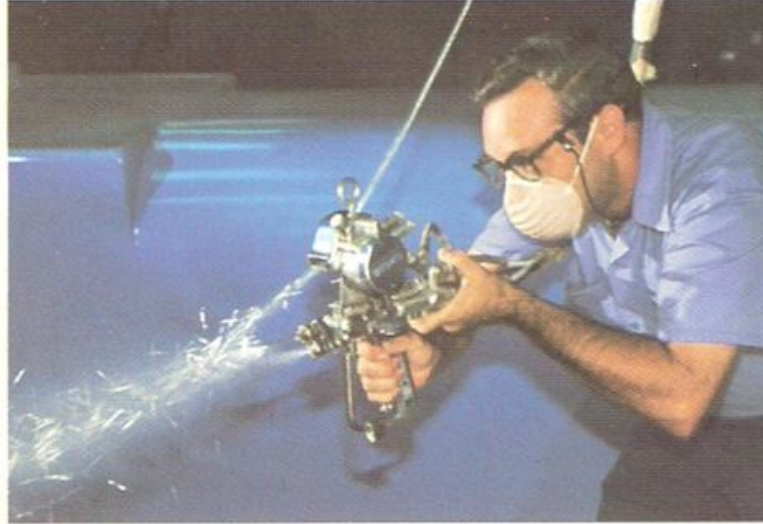
Şekil 2.7. Bağımsız başlıklı spreyl tabancası ile Spray up tekniğinin uygulanması (PPG, 2015)
