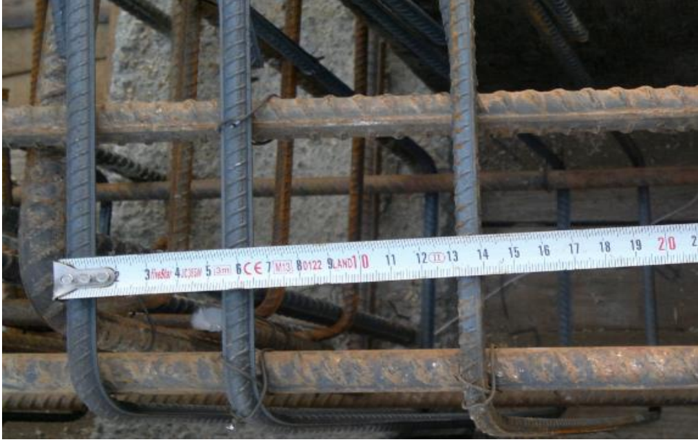
Şekil 5.37. Kirişlerde enine donatı aralığı şartına uyulması
