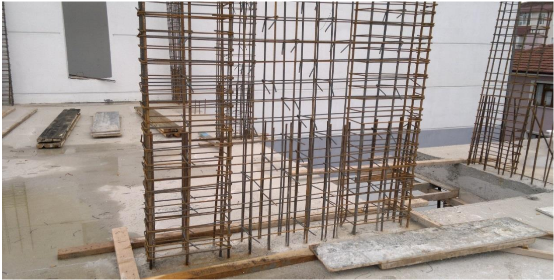
Şekil 5.68. Betonarme perde uç bölgesindeki boyuna donatının şartlara uygun olması durumu
