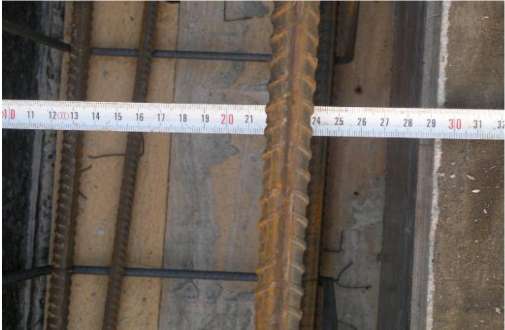
Şekil 5.26. Kiriş gövde genişliği şartına uyulması
