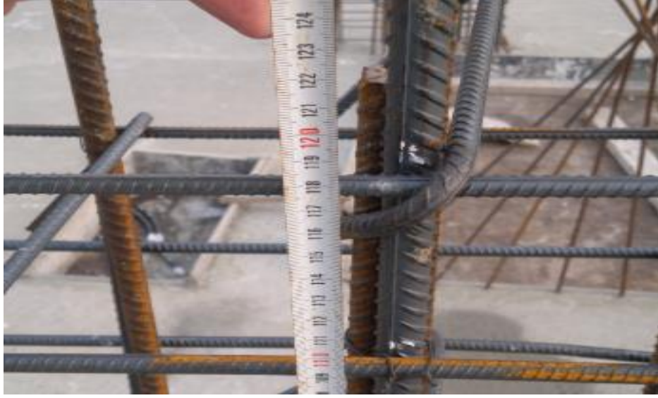
Şekil 5.24. Bindirme boyu şartına uyulması
