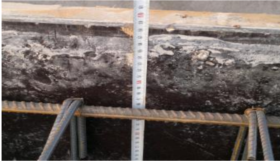
Şekil 5.28. Kiriş yüksekliği şartına uyulması
