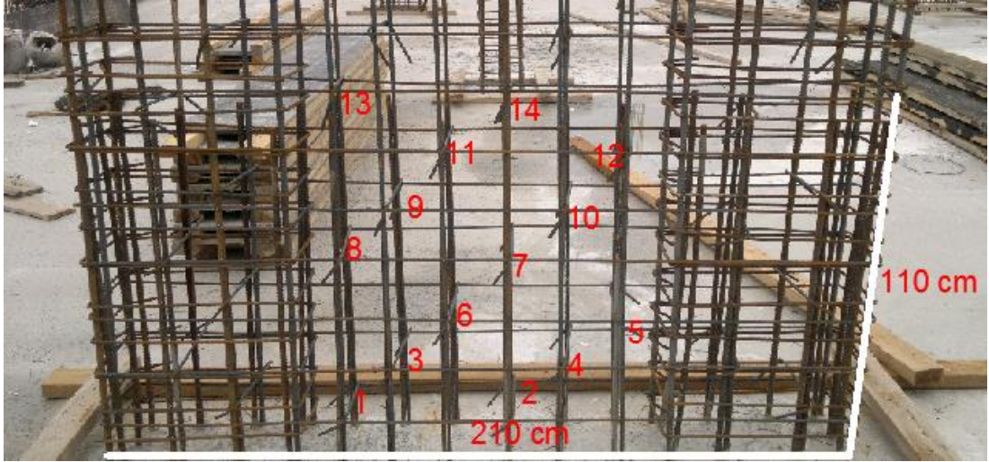
Şekil 5.66. Betonarme perdelerde çiroz kullanılmasına uyulması durumu
