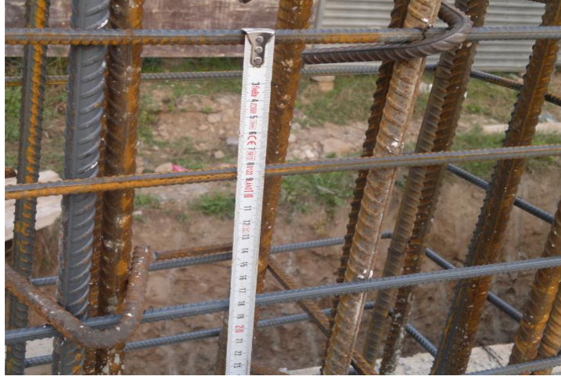
Şekil 5.20. Sarılma ve orta bölgede enine donatı aralığı kuralına uyulması
