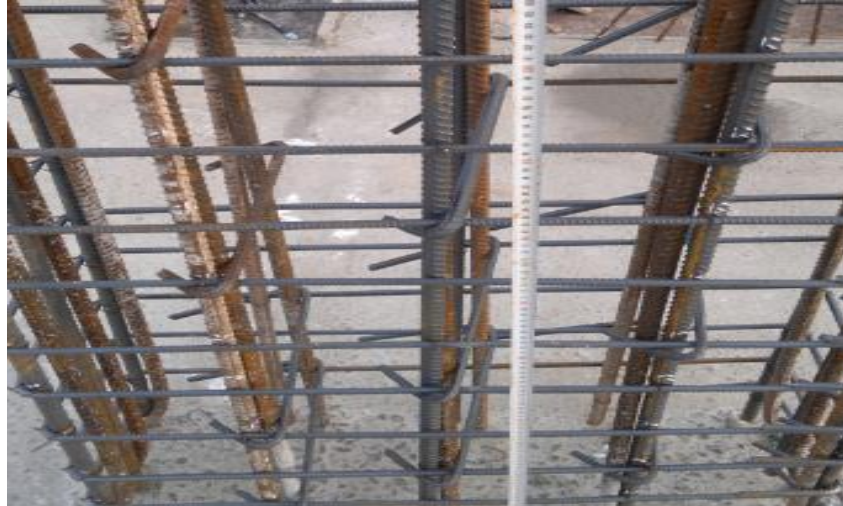
Şekil 5.17 Sarılma bölgesi uzunluğu şartına uyulması
