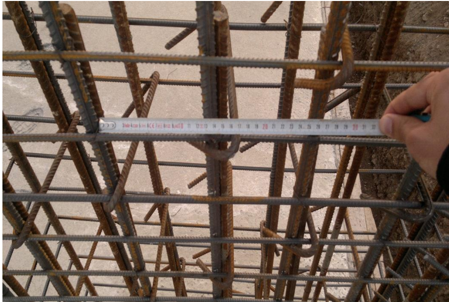
Şekil 5.12. Donatı çubukları arasındaki mesafeye uyulması durumu
