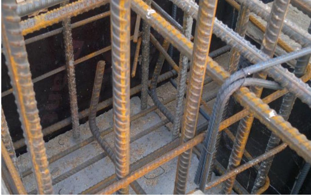
Şekil 5.33. Kirişlerde boyuna donatının 90 derece kıvrılması şartına uyulması
