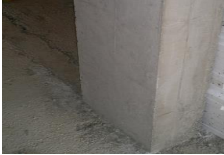
Şekil 5.15. Kolonlarda net beton örtüsü şartına uyulması
