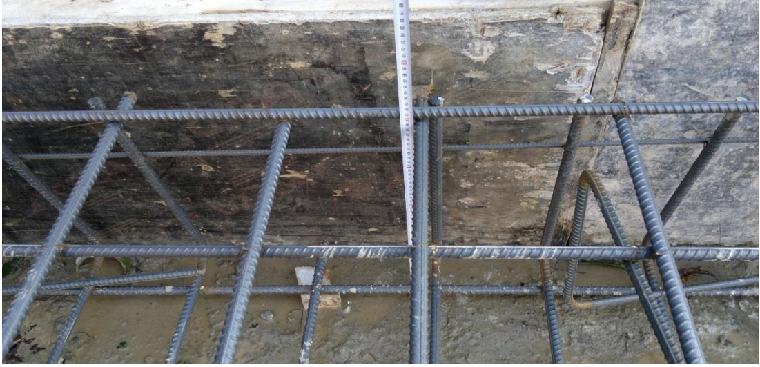
Şekil 5.69. Temelerde net beton örtüsü kalınlığı şartının sağlanması durumu
