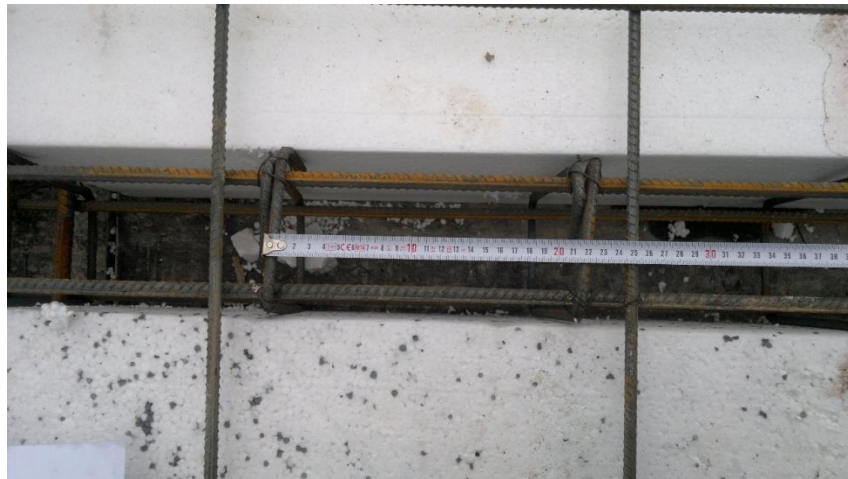
řekil 5.53. Diřli döřemelerde diř için enine donatı aralıđı ile ilgili řarta uyulması durumu
