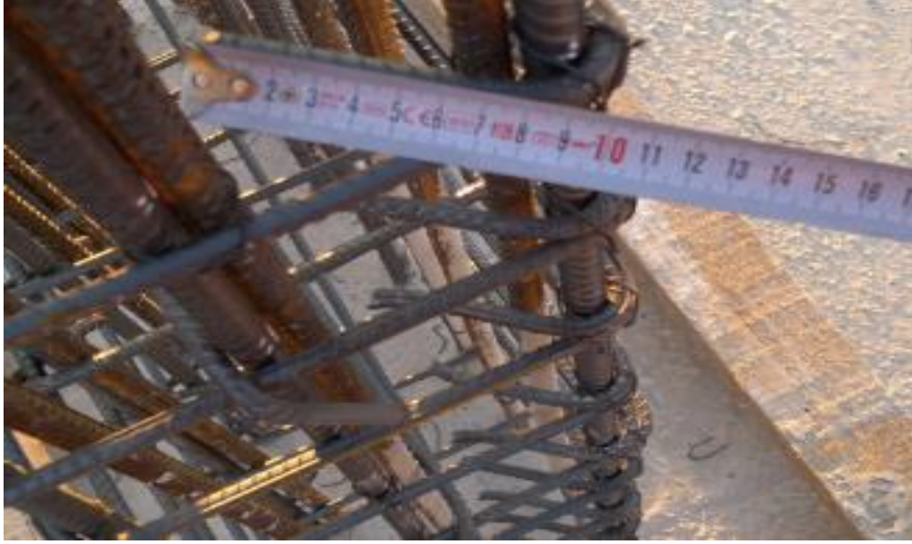
Şekil 5.9.Kanca boyu şartına uyulması
