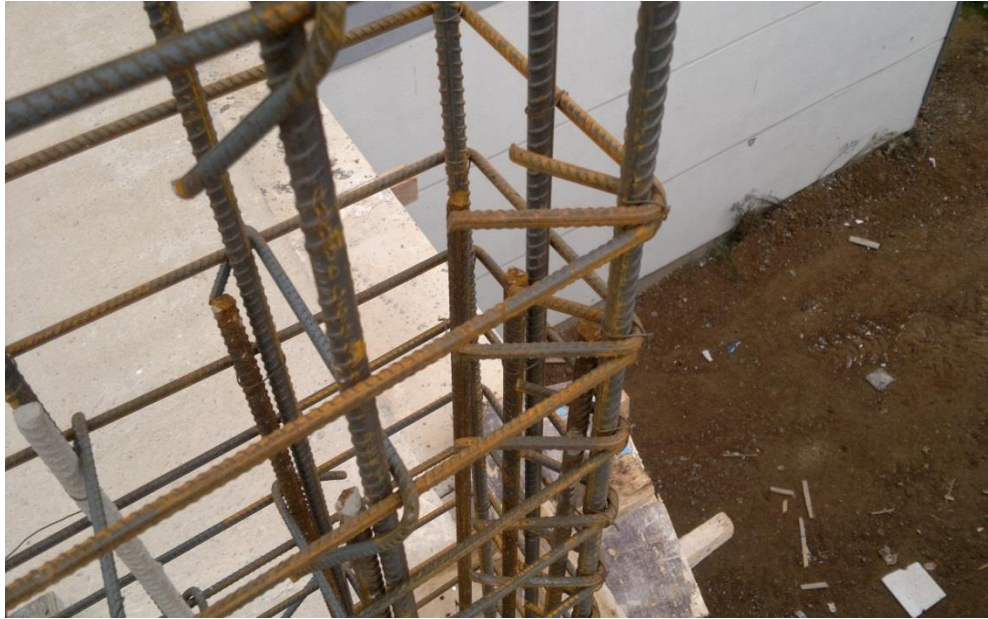
Şekil 5.7. Kanca açısının 135 derece olması durumu
