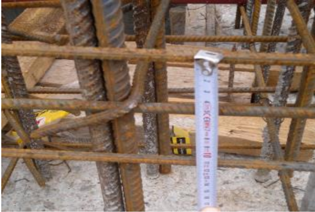
Şekil 5.64. Perde uç bölgesindeki enine donatı aralığı ile ilgili verilen şartlara uyulması durumu
