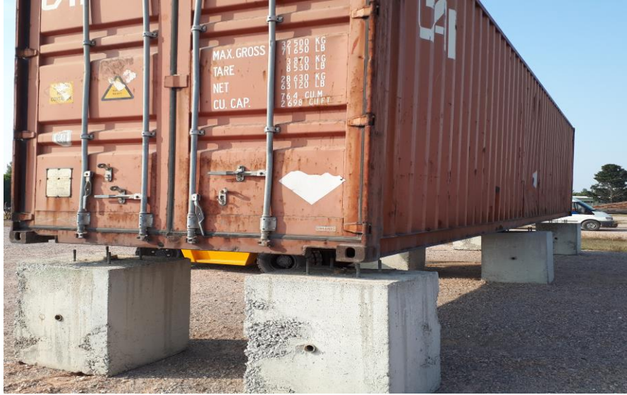
Şekil 6.15. Konteyner'in beton bloklar üzerine yerleştirilmesi
