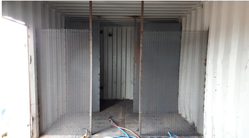
Şekil 6.20. Mutfak, tuvalet ve kokpit bölmelerinin yapım çalışmaları
