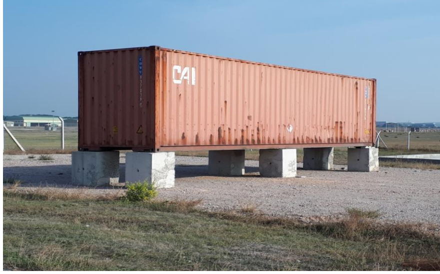
Şekil 6.16. Beton bloklar üzerine yerleştirilmiş konteyner
