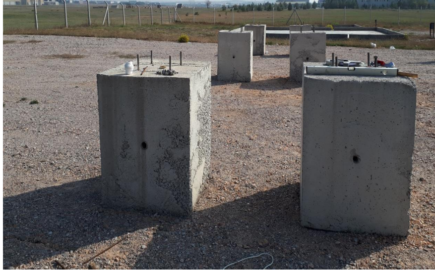
Şekil 6.9. 1x1x1 metrelik beton blokların yerleştirilmesi
