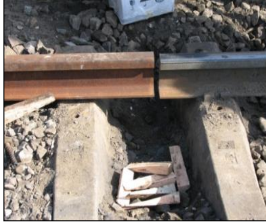
Şekil 6.2. Kaynağa hazır conta [45]
