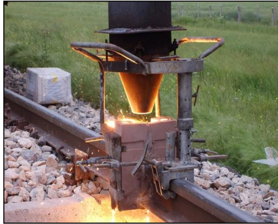
Şekil 6.3. Termitin reaksiyona girdiği pota [54]
