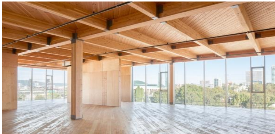
Şekil 2.3. Ahşap döşeme-kiriş elemanı [65]
