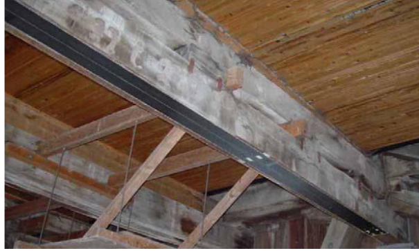
Şekil 3.3. Ahşap taşıyıcı sistemlerin FRP'ler ile güçlendirilmesi
