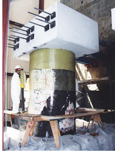
Şekil 3.2. Bir köprünün FRP kompozitler ile sismik güçlendirme
