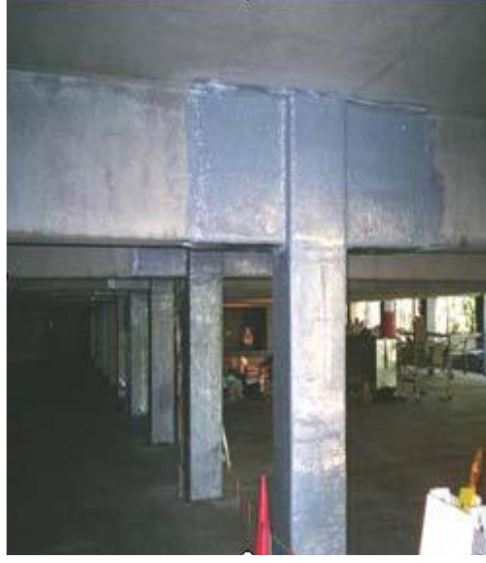
Şekil 3.1. FRP'lerle güçlendirilmiş betonarme kolonlar
