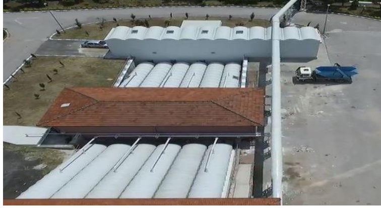
Şekil 2.2. Üzeri Kapatılan Giriş Yapısı Üniteleri
