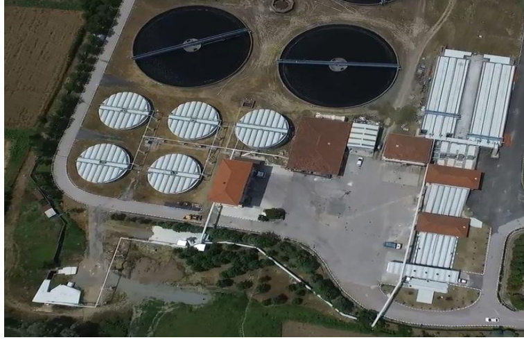
Şekil 2.1. Üzeri Kapatılan Ünitelerin Görünüşü
