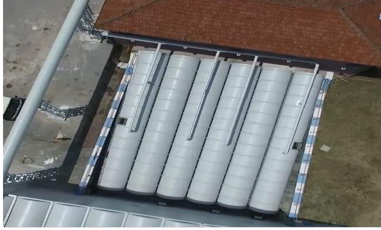
Şekil 2.3. Üzeri Kapatılan Arşimedyen Pompa Bölümü
