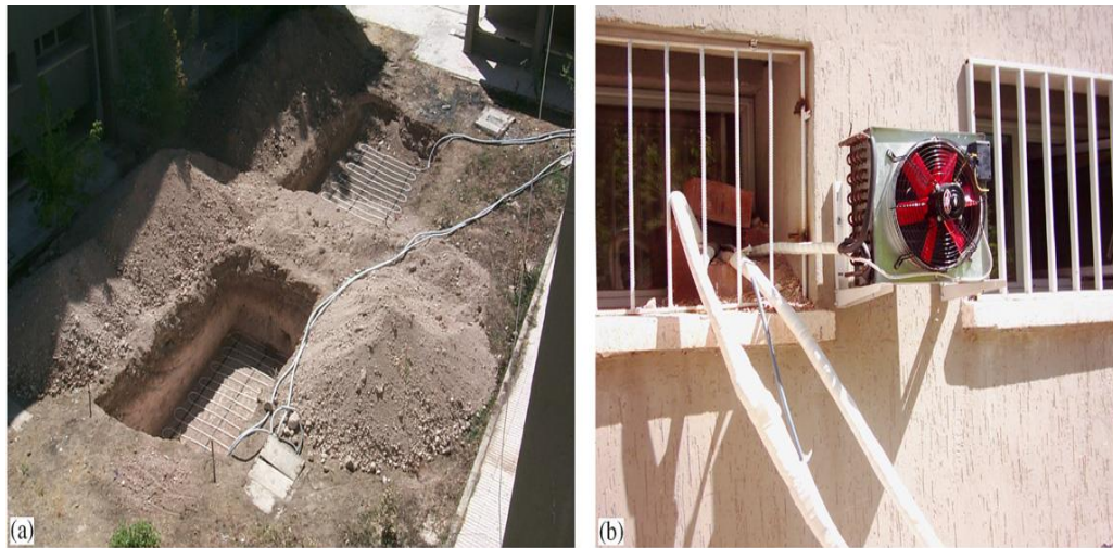
Şekil 2.6. GSHP (a) ve ASHP (b) sistemleri (Esen ve ark., 2007).
