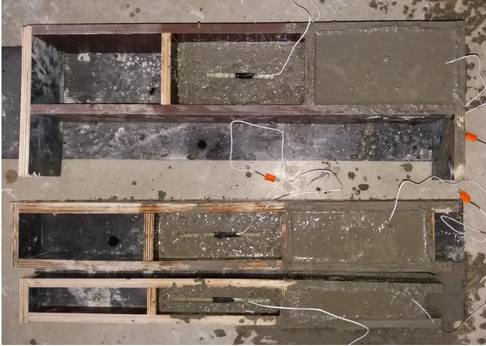
Şekil 4.14. Beton döküm aşaması
