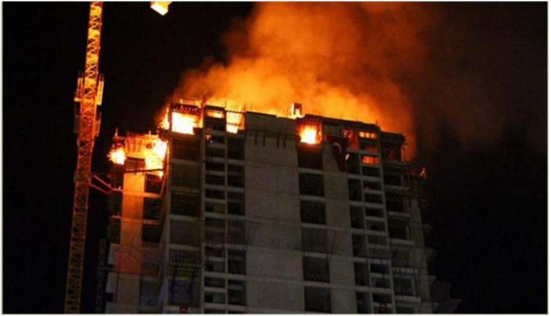
Şekil 3.1. Betonarme binada yangın [90]
