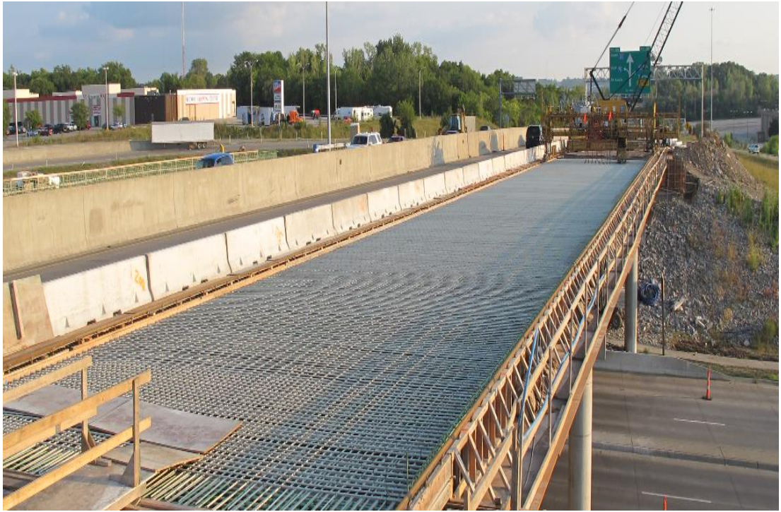
Şekil 2.10. Köprü yapımında FRP donatı kullanımı [92]
