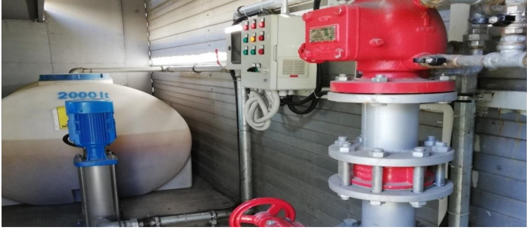
Şekil 5.10. Model otomotiv sanayisinde köpük su sistemi (Köpük tankı ,sistem pompası )
