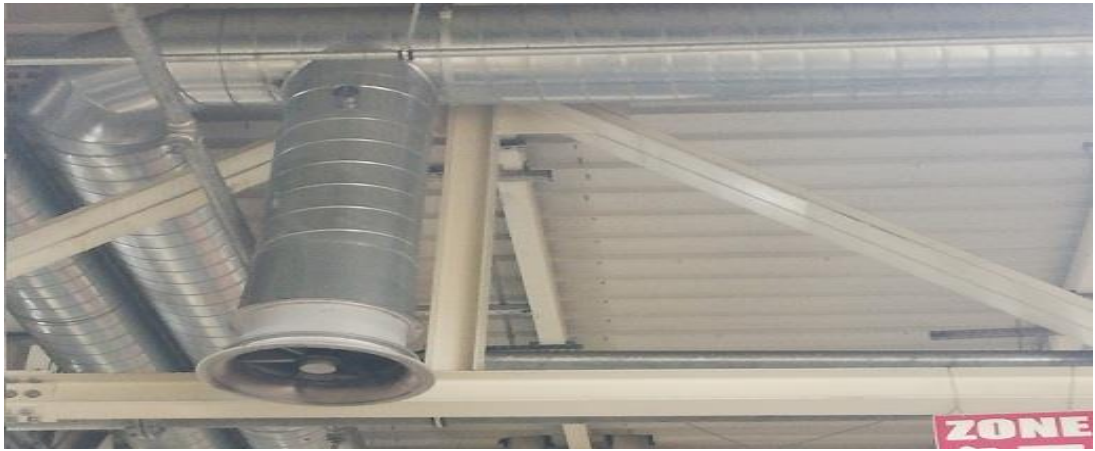
Şekil 5.37. Model otomotiv sanayisinde exproof havalandırma sistemi
