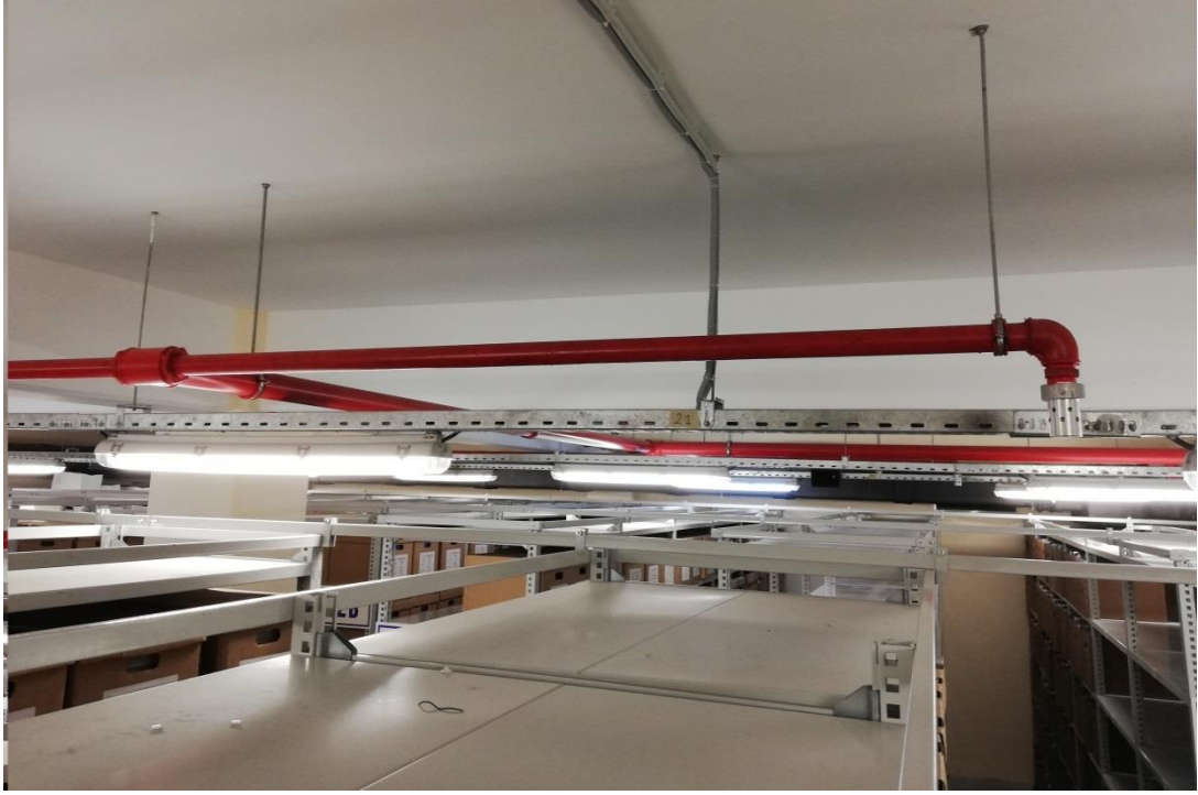
Şekil 5.15. Model otomotiv sanayisinde arşiv alanında kullanılan FM 200 söndürme sistemi
