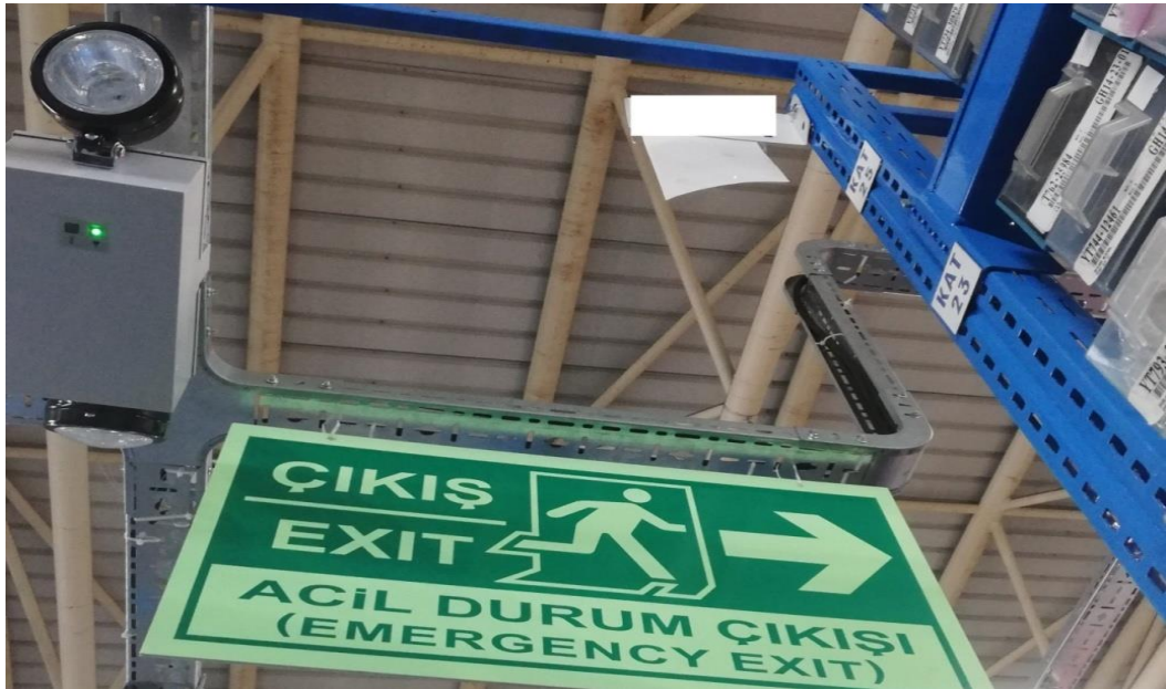
Şekil 5.27. Model otomotiv sanayisinde bataryalı aydınlatma ve acil durum yönlendirme levhası
