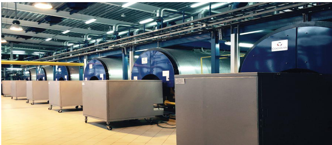
Şekil 2.8. Sıcak su kazanı [16].
