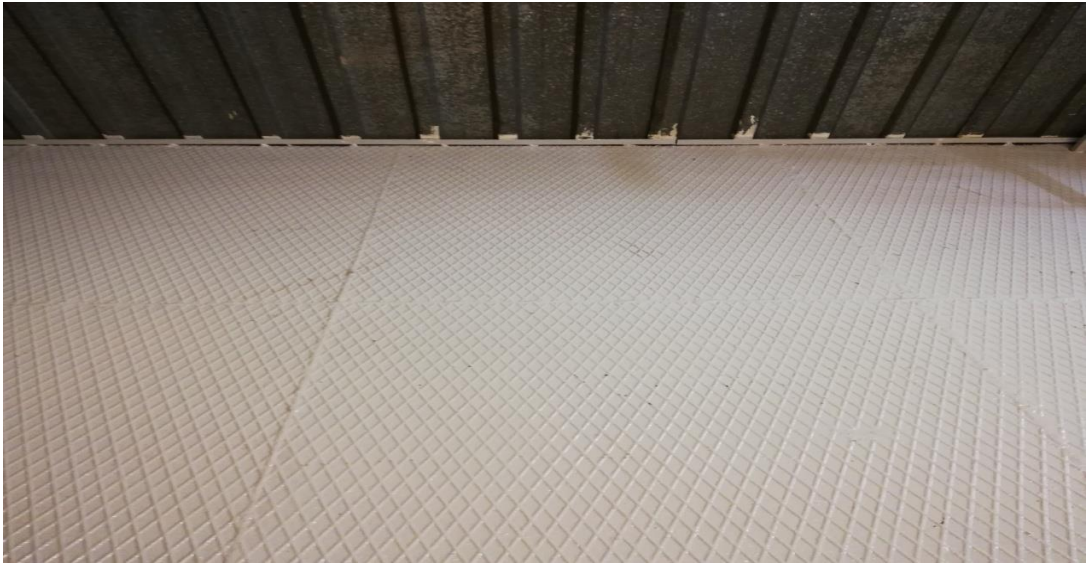
Şekil 5.24. Model otomotiv sanayisinde yanmaz boya ile boyanan zemin
