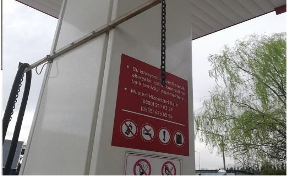
Şekil 5.31. Model otomotiv sanayisinin yakıt istasyonunda statik elektriğe karşı zincir
