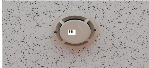
Şekil 5.1. Model otomotiv sanayisinde kullanılan duman dedektörü
