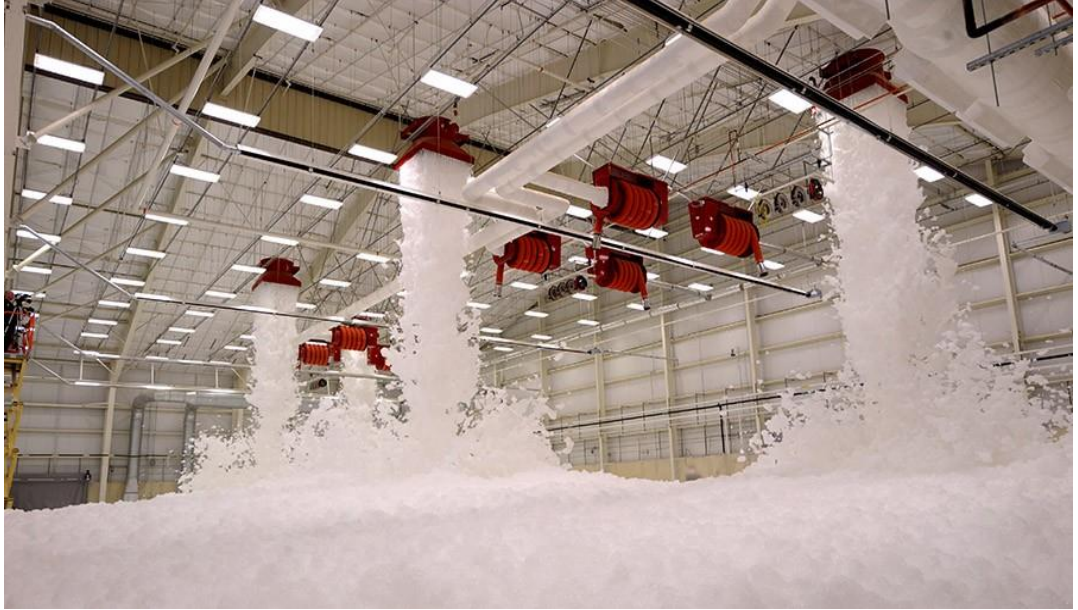
Şekil 4.9. Köpük yangın söndürme sistemleri [33].
