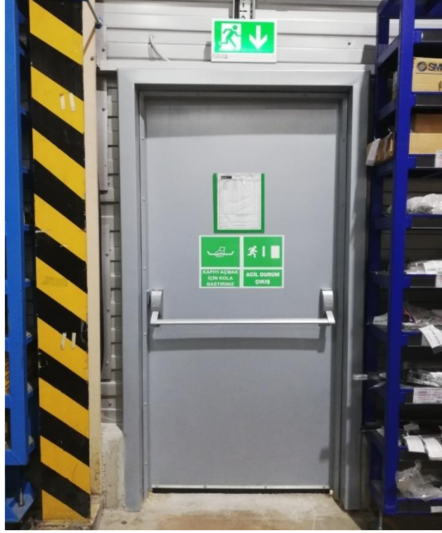
Şekil 5.26. Model otomotiv sanayisinde acil durum aydınlatması ve levhası
