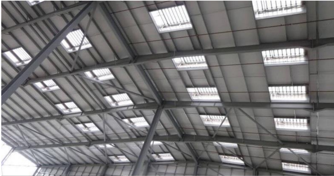
Şekil 4.22. Doğal açıklıklı duman tahliye [60].
