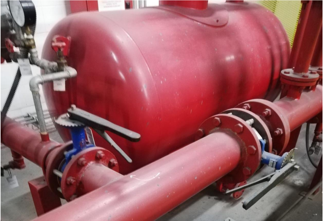
Şekil 5.13. Model otomotiv sanayisinde kabinlere ait köpük tankı
