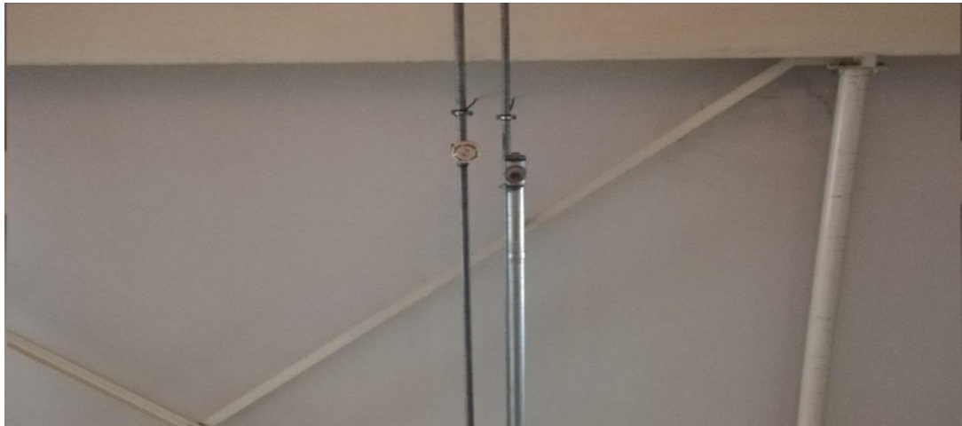
Şekil 5.11. Model otomotiv sanayisinde köpük su sistemi nozulu ve ısı dedektörü
