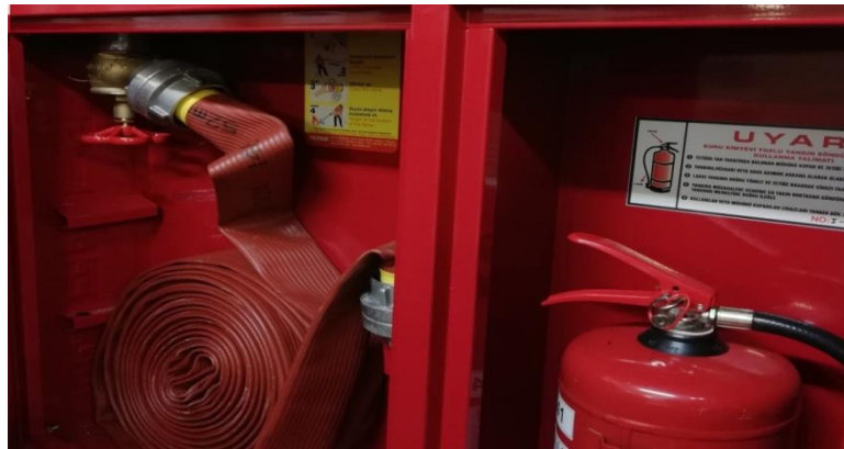
Şekil 5.17. Model otomotiv sanayisinde yangın dolabı
