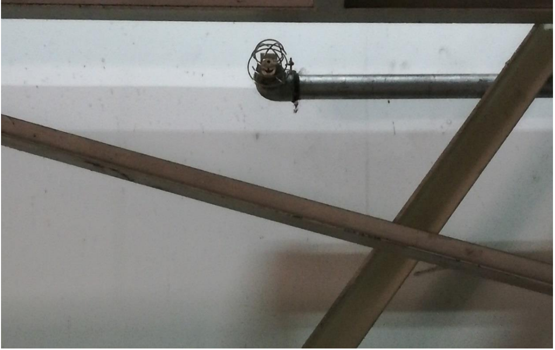
Şekil 5.12. Model otomotiv sanayisinde köpük su sistemi nozulu
