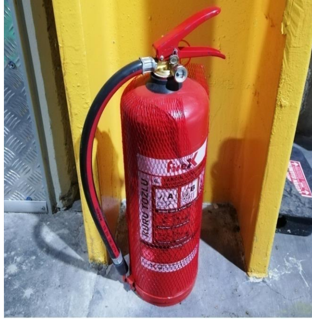
Şekil 5.5. Model otomotiv sanayisinde kullanılan KKT (Kuru Kimyevi Tozlu) yangın söndürücü cihaz
