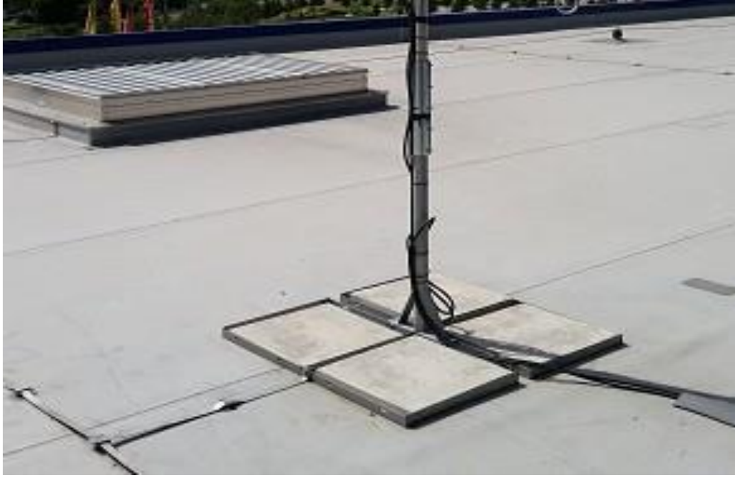
Şekil 4.26. Paratoner sistemi [66].
