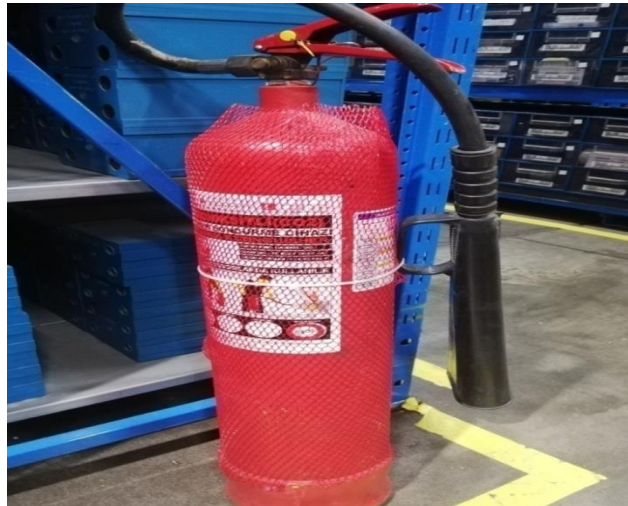
Şekil 5.6. Model otomotiv sanayisinde kullanılan CO2 (Karbondioksit) yangın söndürücü cihaz
