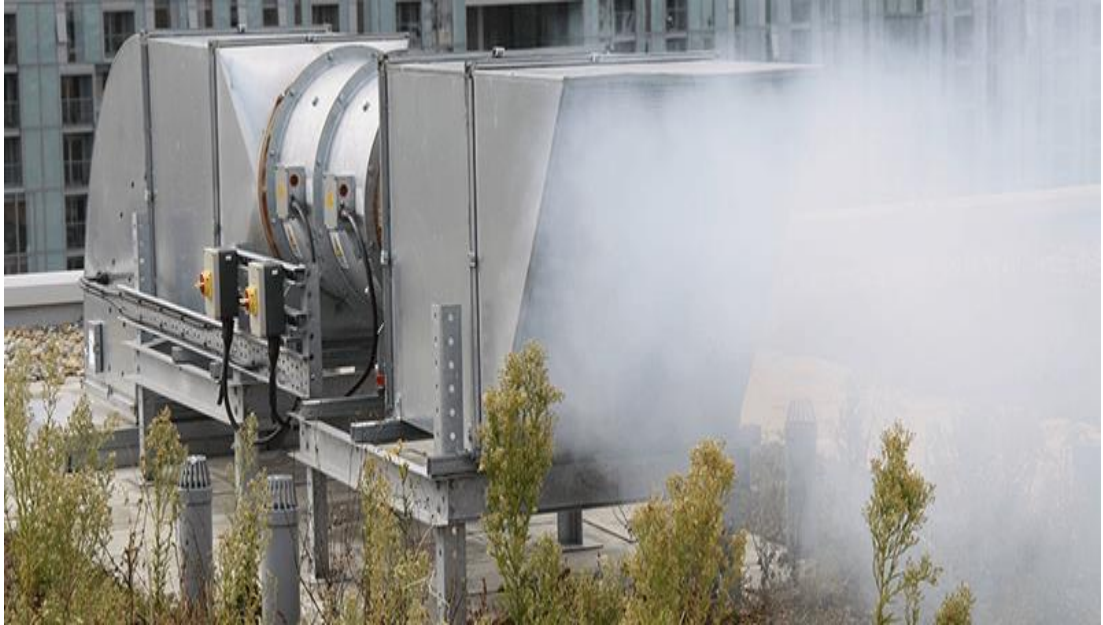
Şekil 4.23. Mekanik duman tahliye [60].
