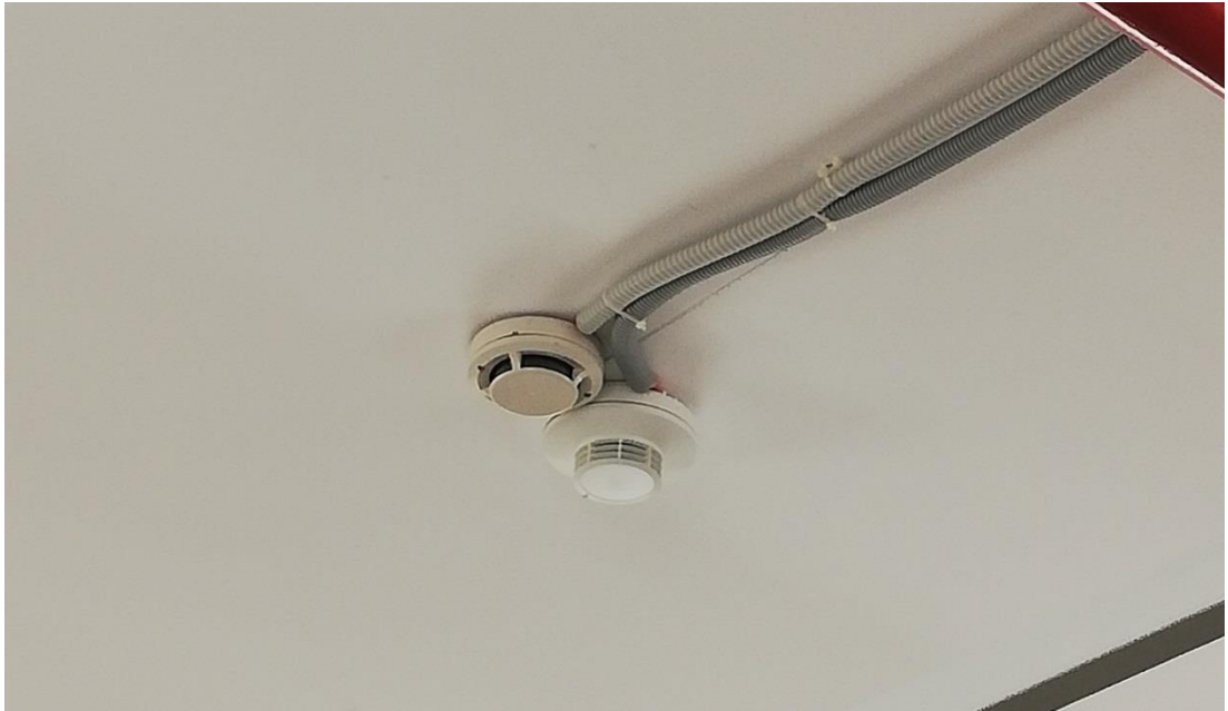
Şekil 5.3. Model otomotiv sanayisinde ısı ve duman dedektörü
