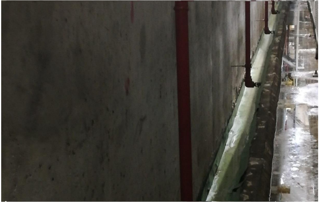
Şekil 5.7. Model otomotiv sanayisinde otomatik borulu yangın söndürme sistemi
