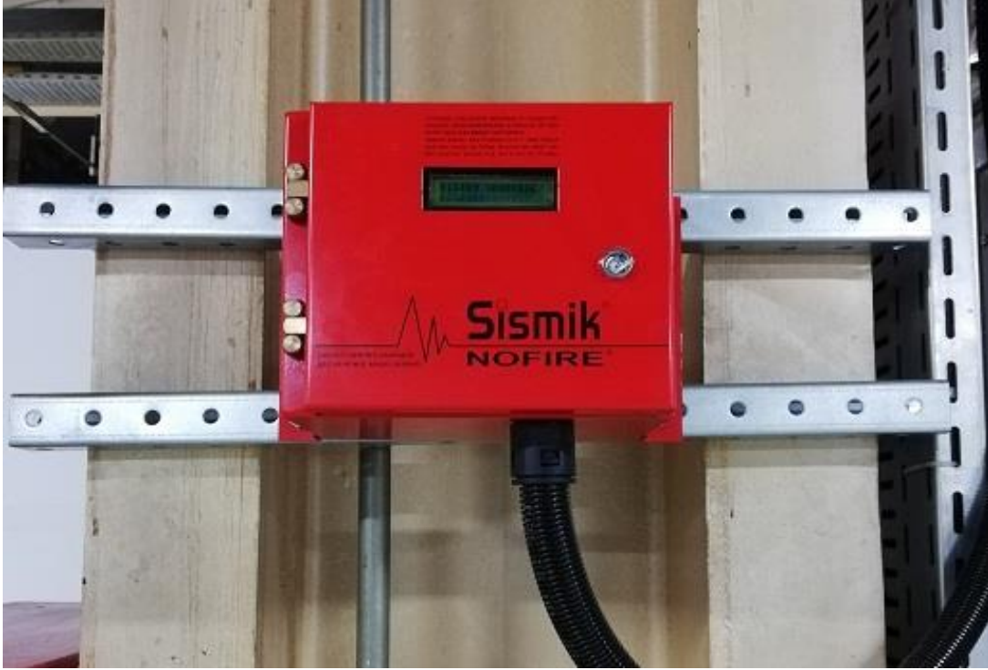
Şekil 5.4. Model otomotiv sanayisinde deprem sensörü
