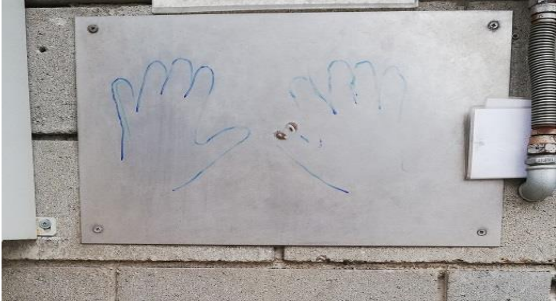
Şekil 5.29. Model otomotiv sanayisinde statik elektriğe karşı plaka
