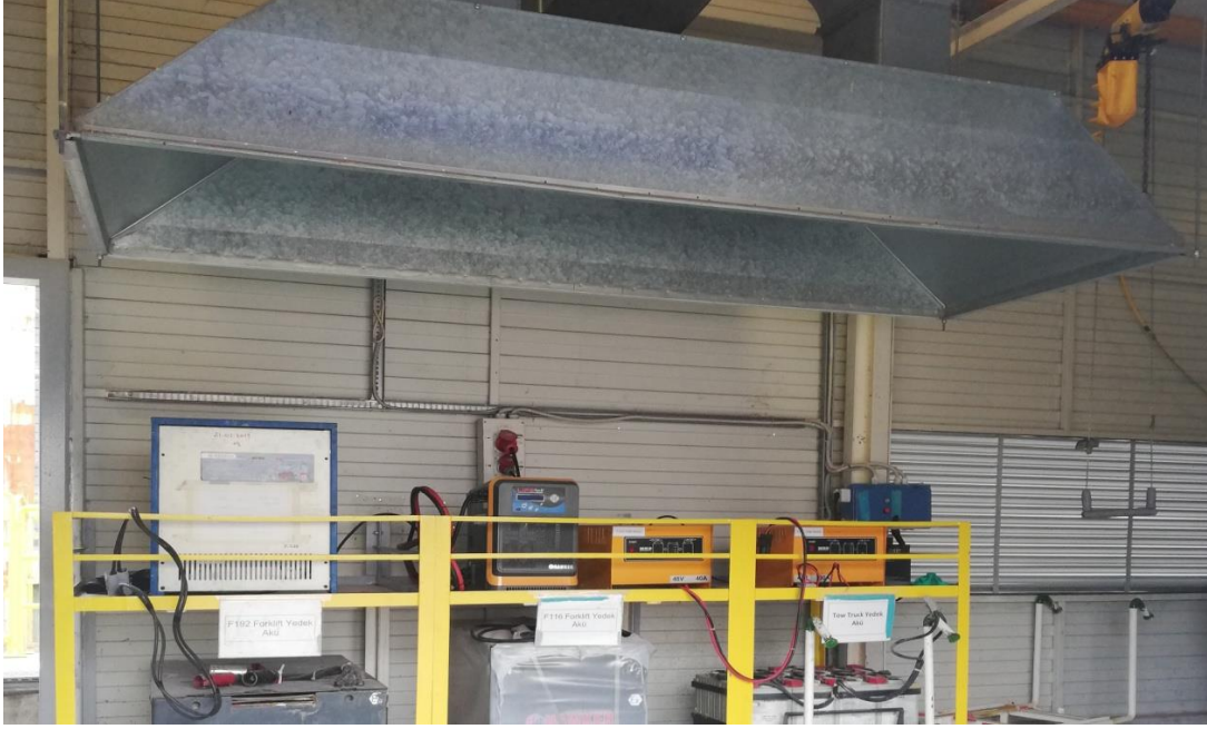
Şekil 5.20. Model otomotiv sanayisinde akü şarj alanı
