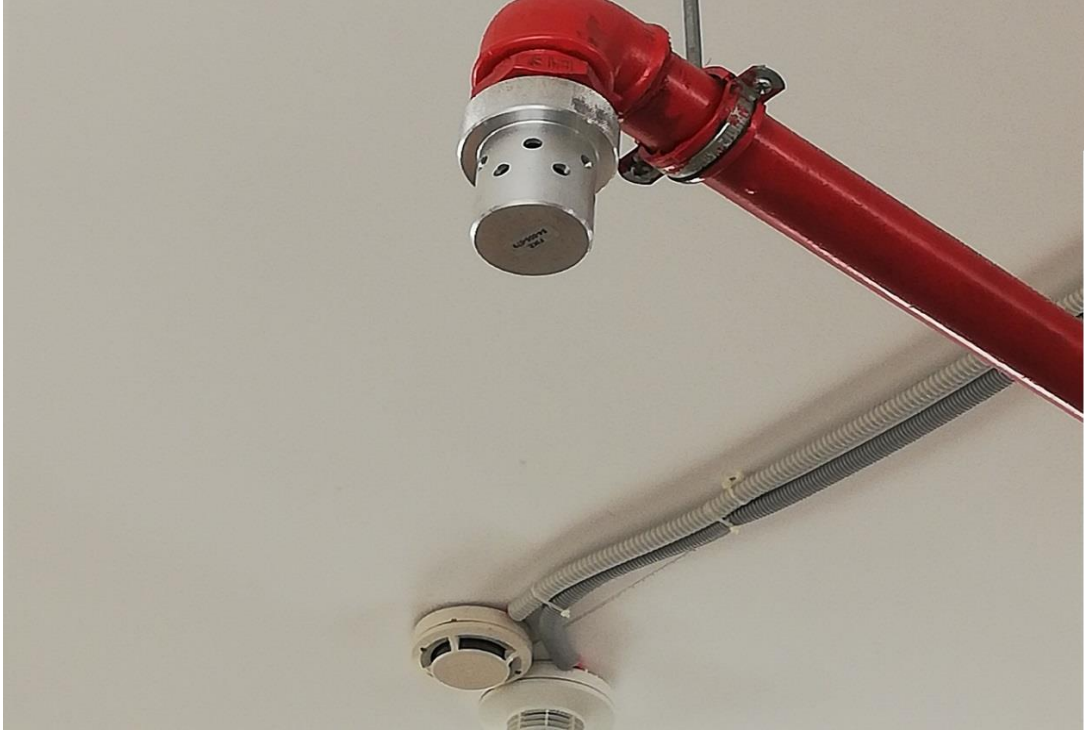
Şekil 5.14. Model otomotiv sanayisinde dedektörler ve gazlı yangın söndürme sistemi
