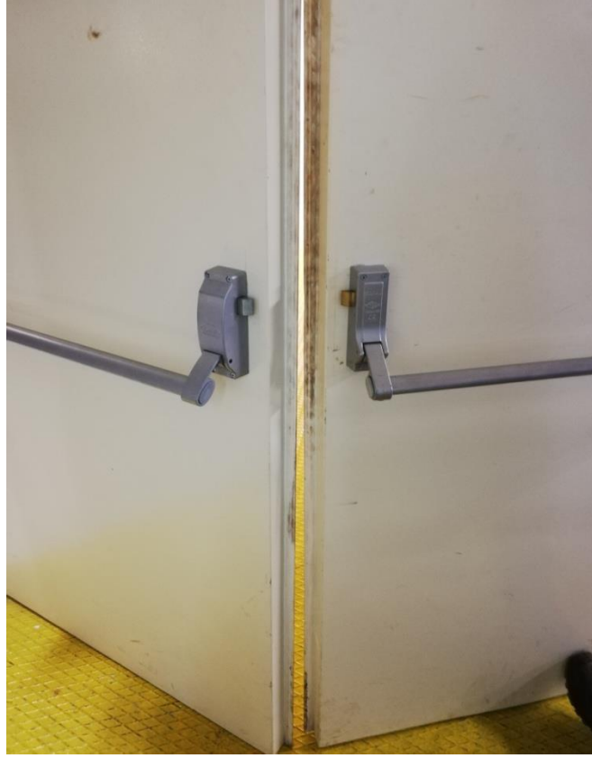
Şekil 5.35. Model otomotiv sanayisinde hatalı uygulama olan acil çıkış kapıları
