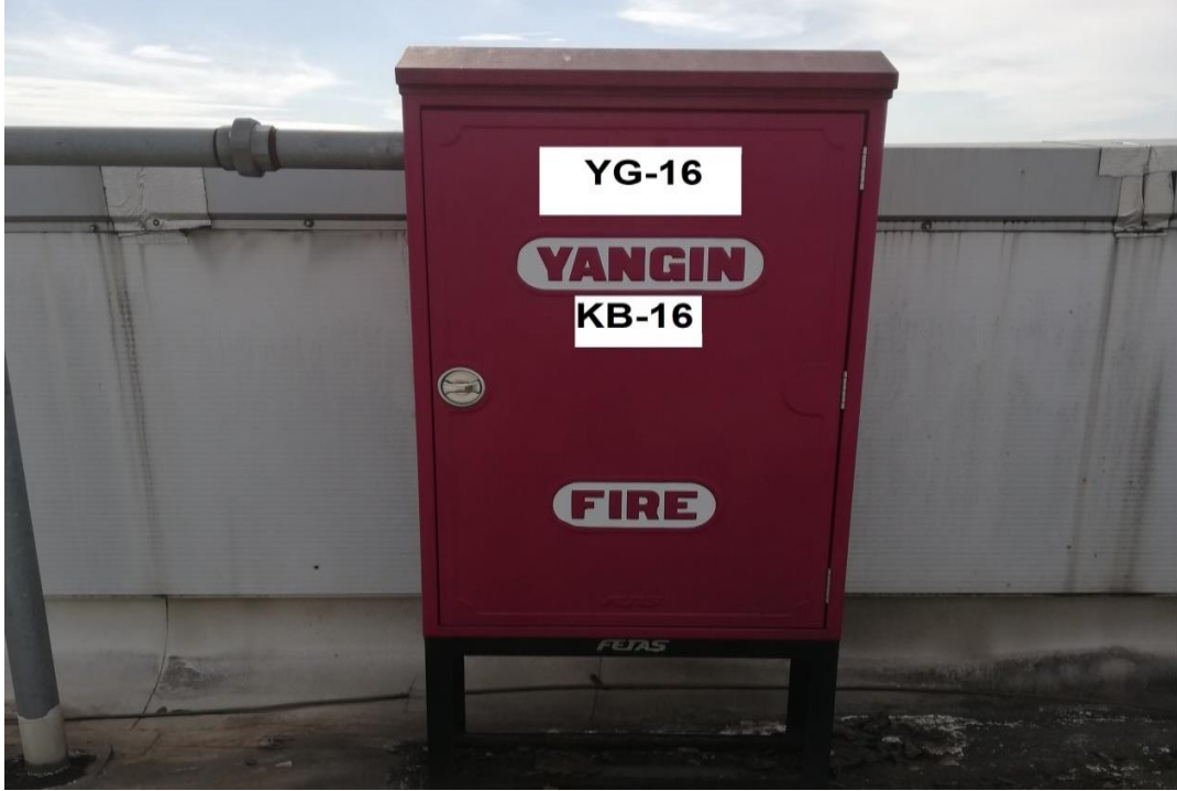
Şekil 5.18. Model otomotiv sanayisinde kuru boru hattı ve hortum sistemi
