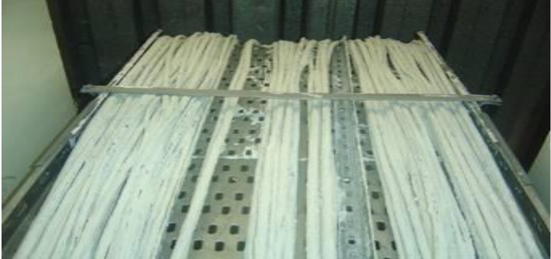
Şekil 5.25. Model otomotiv sanayisinde yanmaz boya ile boyanmış kablo
