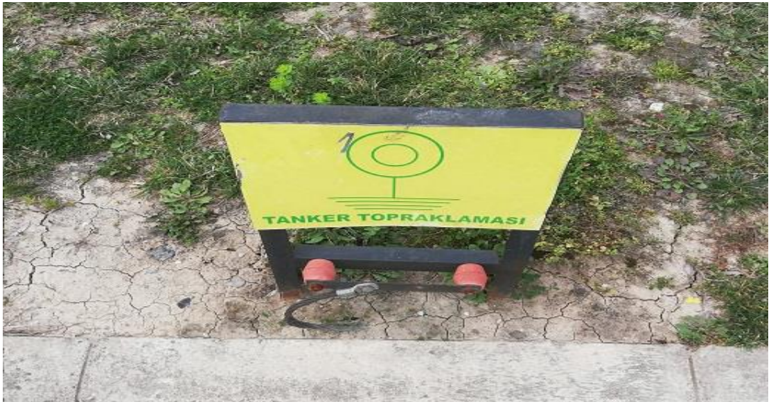
Şekil 5.30. Model otomotiv sanayisinde yakıt tankeri için topraklama hattı
