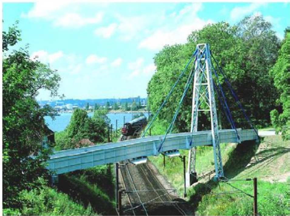
Şekil 2.25. Tamamı kompozit fiber optik kablo hattı, Danimarka (Mosallam, 2014)
