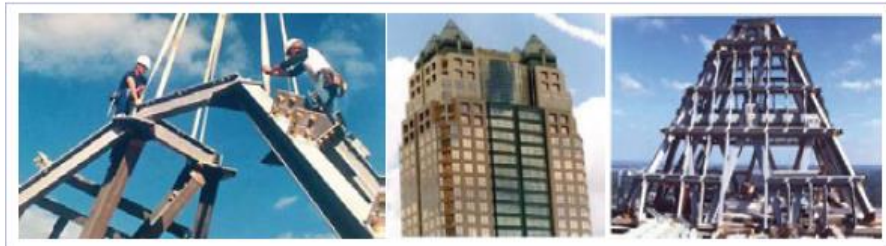
Şekil 2.23. 10,7 m yükseklik x 10,7 m kare zeminde pultrüzyon yöntemiyle üretilen taret kulesi, Orlando, Florida, ABD(Mosallam, 2014)
