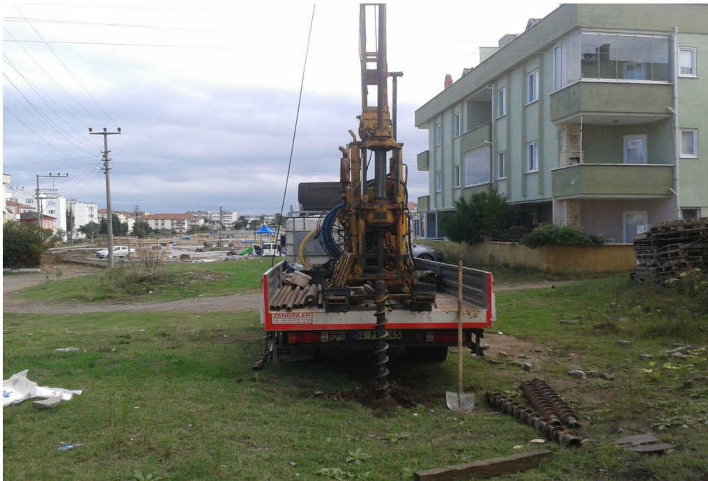
Şekil 3.5. Sondajdan genel bir görünüm
