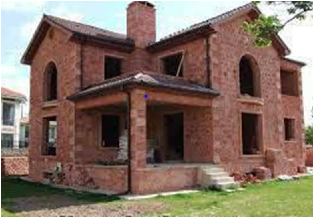
Şekil 1.4. Örnek yığma tuğla yapı ( http://www.google.com )
