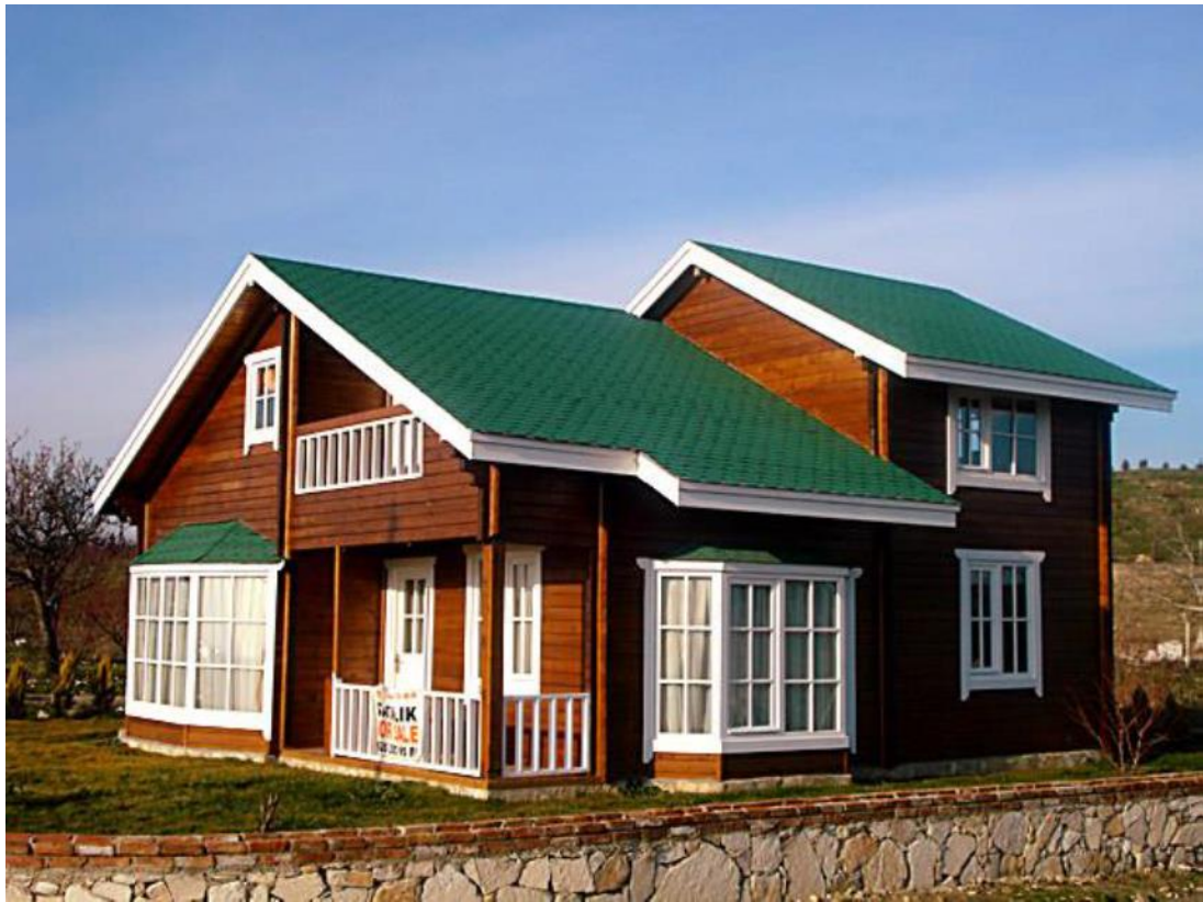
Şekil 1.2. Örnek yığma ahşap yapı ( http://www.google.com )
