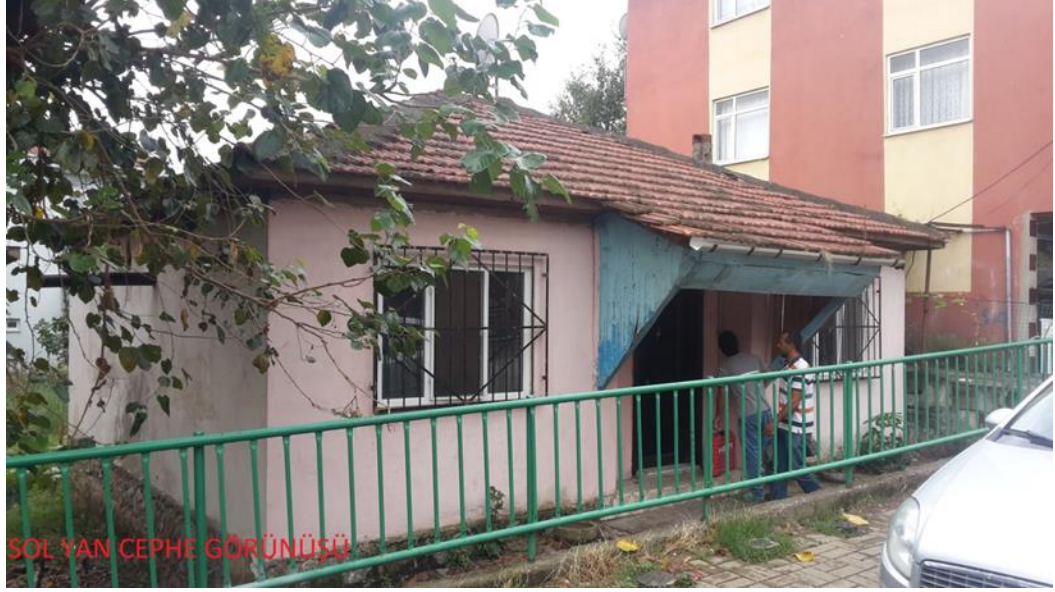
Şekil 6.1. İncelenen yiğma yapı
