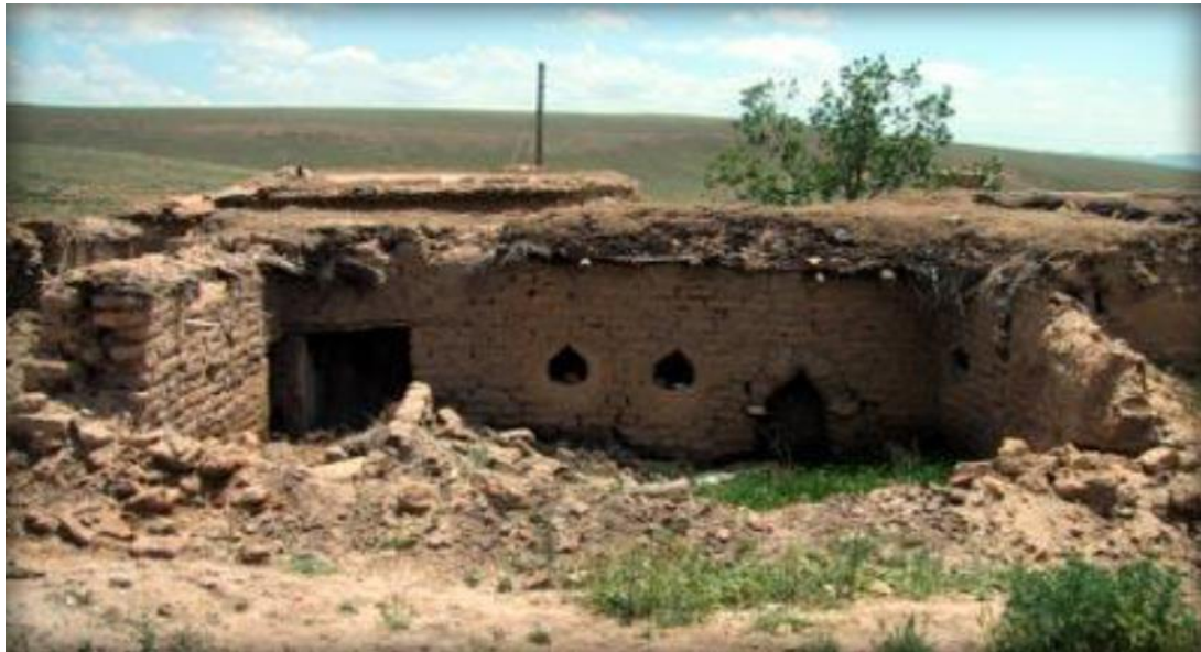
Şekil 1.5. Örnek yığma kerpiç yapı ( http://www.google.com )
