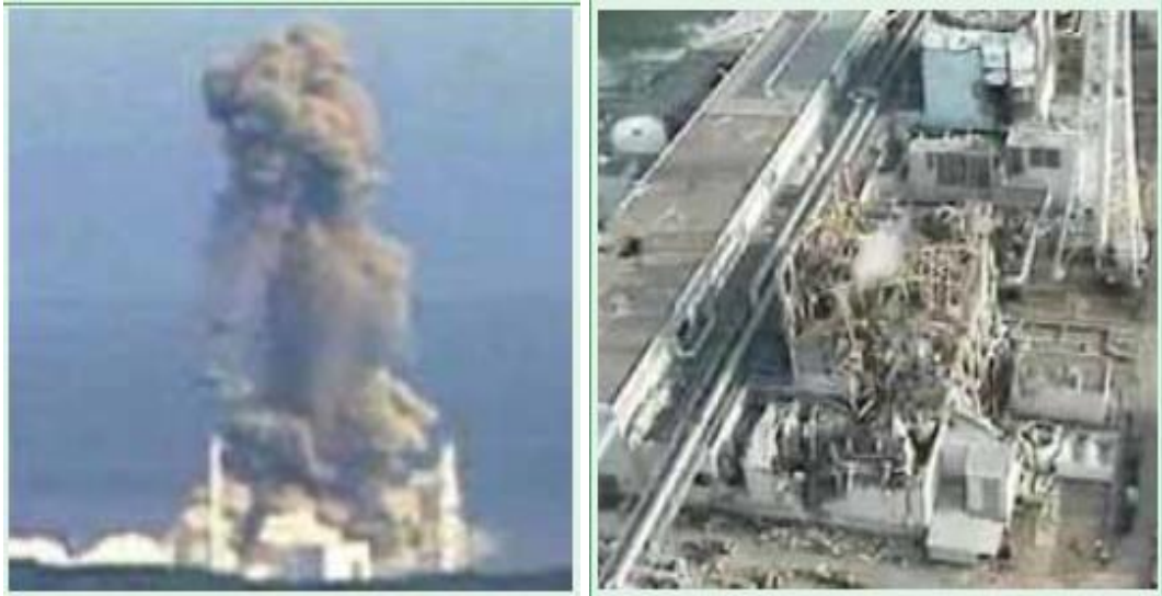
Őekil 5.2. Fukuřima genel elektrik santrali hidrojen gazı patlama anı ve sonrası [35].
