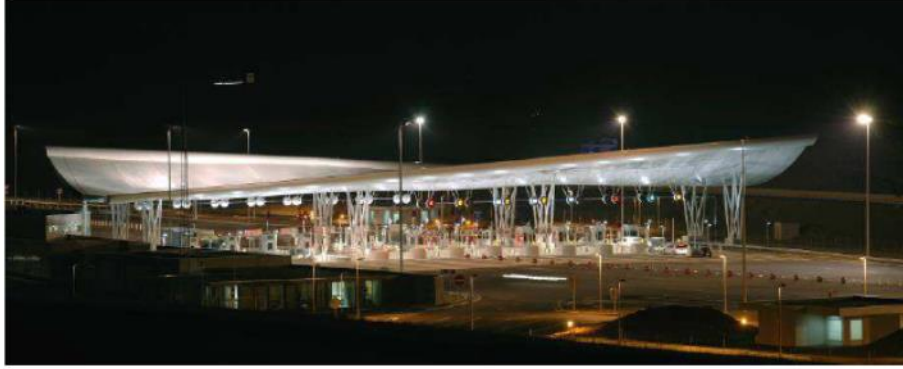
d) Çatı uygulaması
