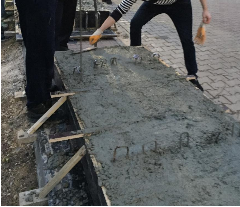
Şekil 3.15. Beton yüzeyi tesviye işlemi
