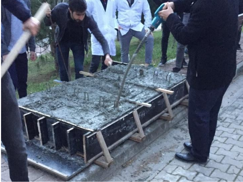
Şekil 3.14. Beton yerleştirme işlemi
