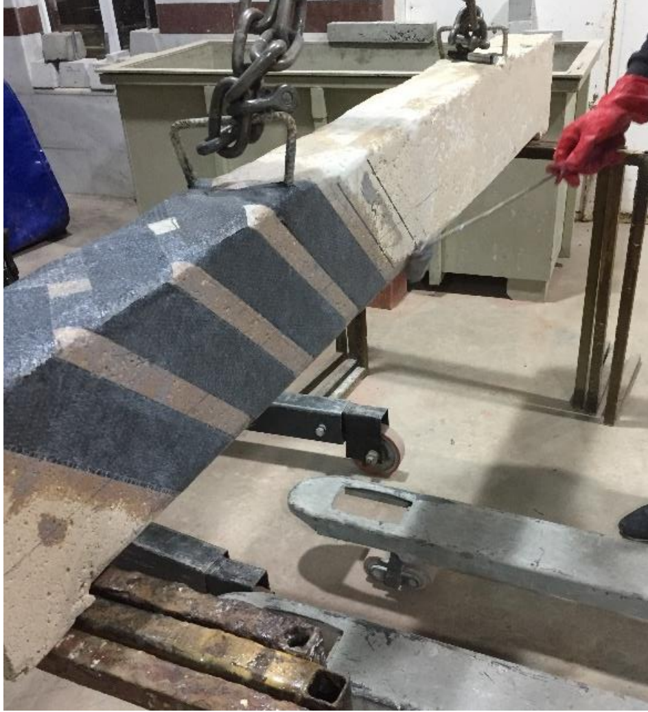
Şekil 3.19. Beton yüzeyine epoksi uygulanması
