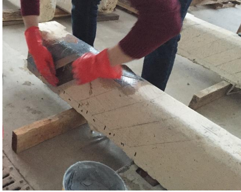
Şekil 3.20. BFRP şeritlerin yapıştırılması
