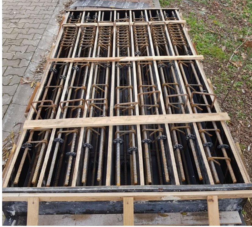
Şekil 3.12. Beton dökümünden önce kalıp ve donatı görünümü
