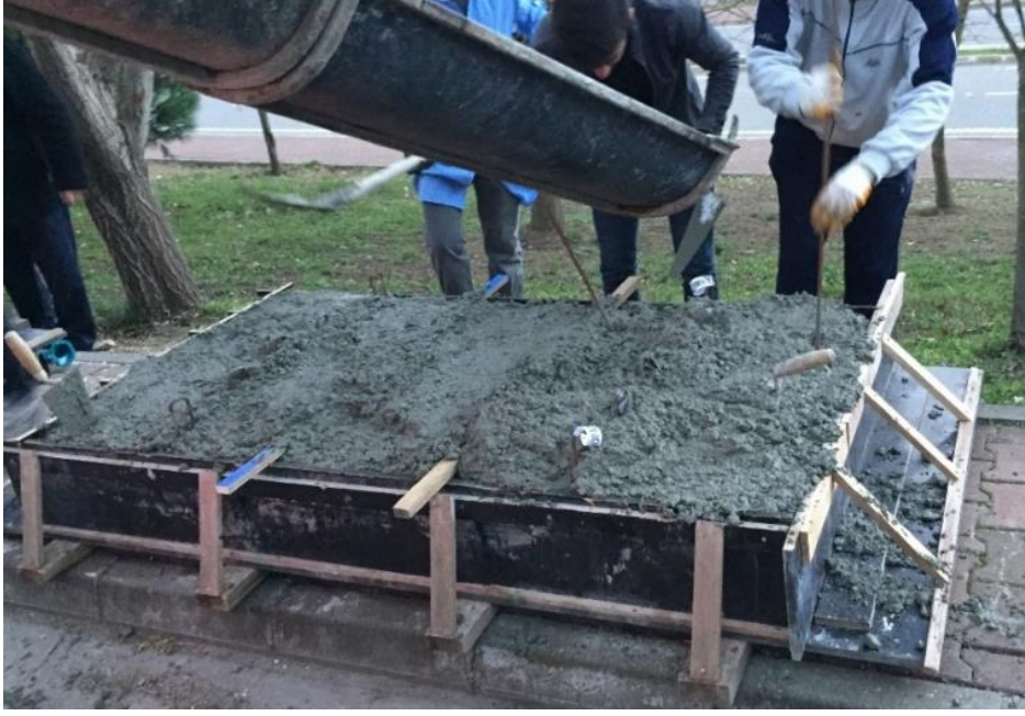
Şekil 3.13. Beton dökümü işlemi
