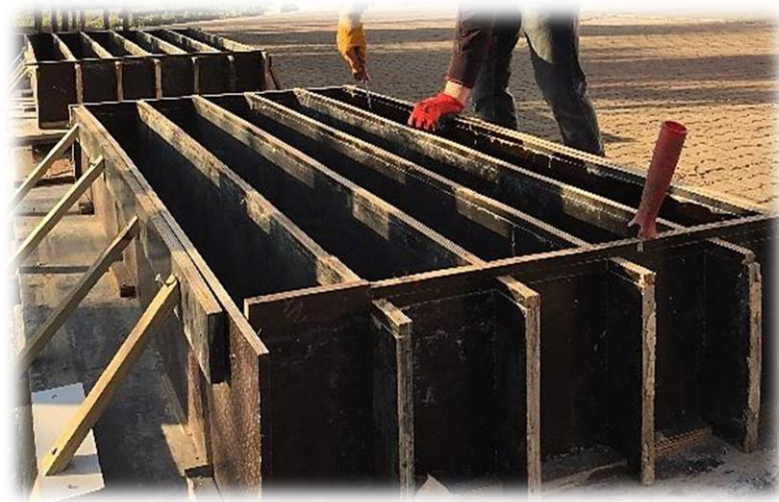
Şekil 3.15. Kalıpları plywood yağı ile yağlandırılması
