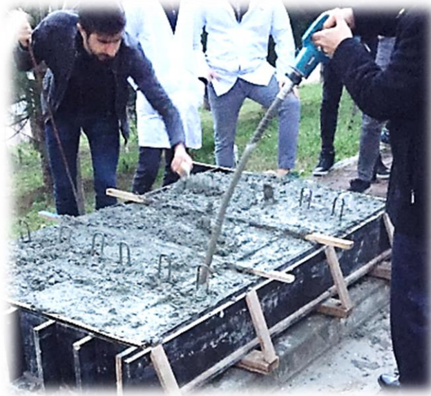
Şekil 3.20. Beton dökümü ve yerleştirilmesi
