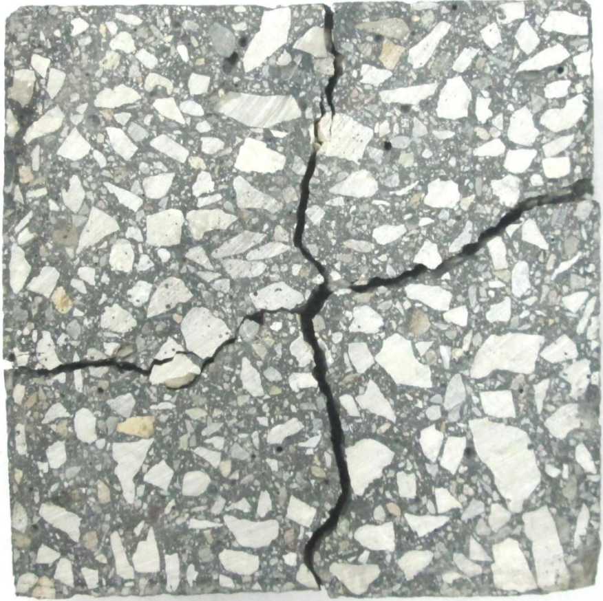
Şekil A.5. Çarpma deney sonrası plaka numunesinin arka yüzeyinden görünüş.
