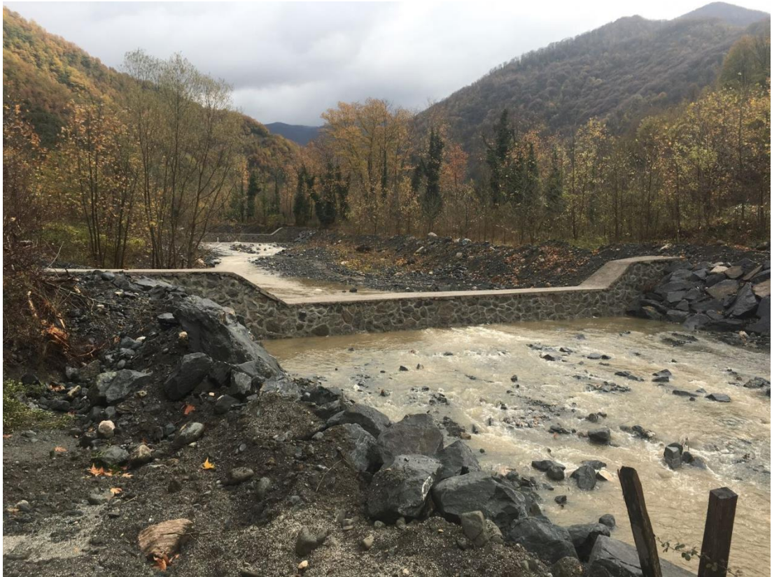
Şekil 2.15. Sakarya Doğançay Deresinde inşa edilen harçlı kargir seki
