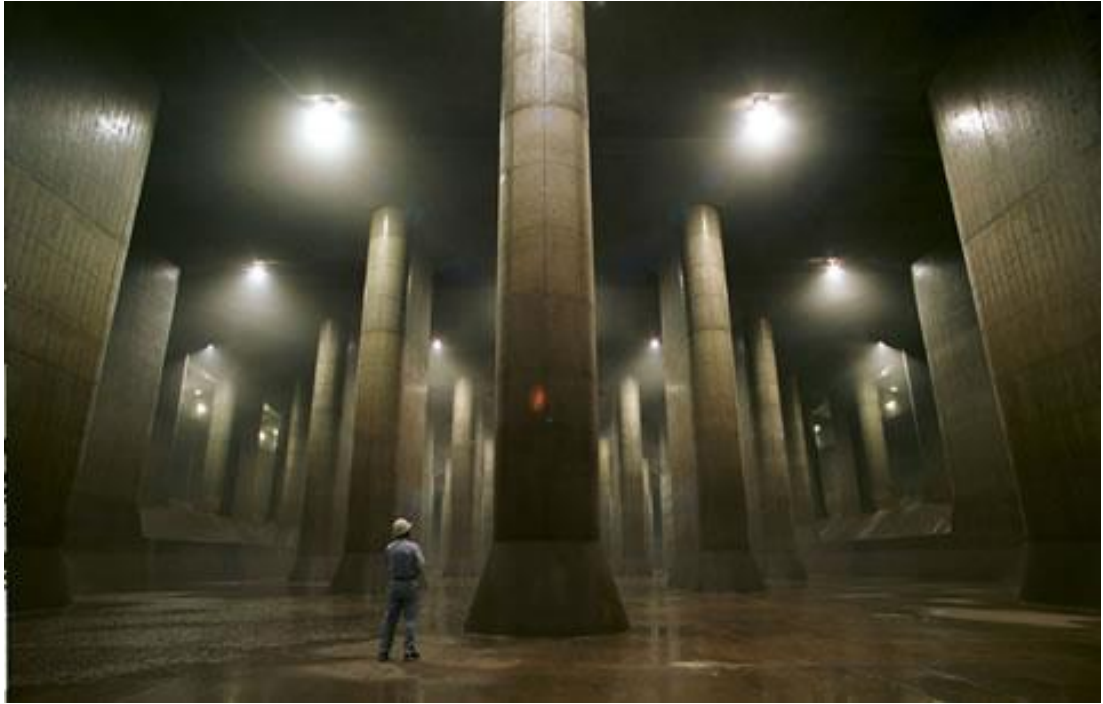
Şekil 2.10. Japonya' nın Tokyo şehrinde inşa edilen taşkın geciktirme havuzu (URL 4).
