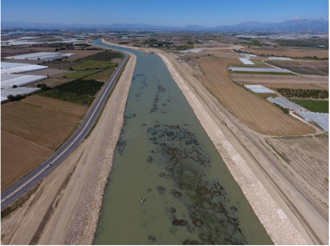
Şekil 2.8. Antalya Aksu Çayında inşa edilen taşkın seddeleri (URL 3).
