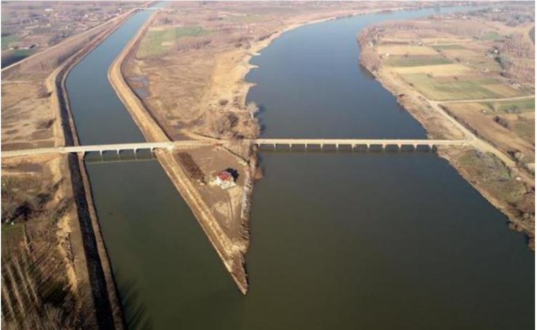
Şekil 2.9. Meriç Nehrinde uygulanan taşkın kanalı (URL 3).
