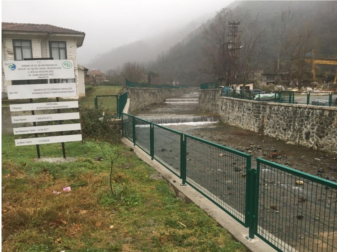
Şekil 2.13. Sakarya Doğançay Deresinde inşa edilen taşkın duvarları
