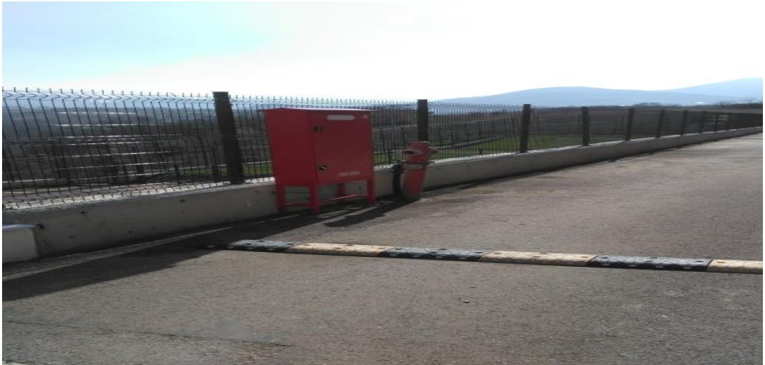
Şekil 5.9. Hidrant
