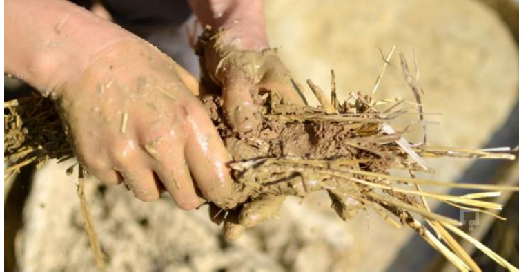
Şekil 2.9. Kerpiç Malzemeleri
