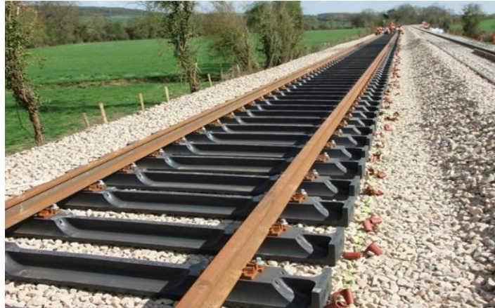
Şekil 3.24. Plastik travers uygulaması
