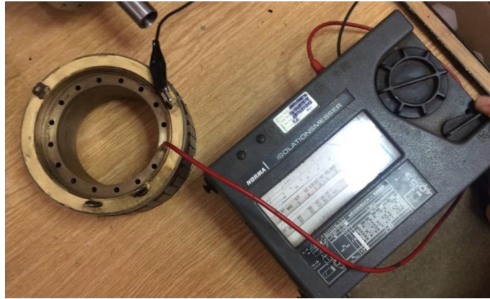
Şekil 5.21. İkaz rotorunun izolasyon direncinin ölçülmesi
