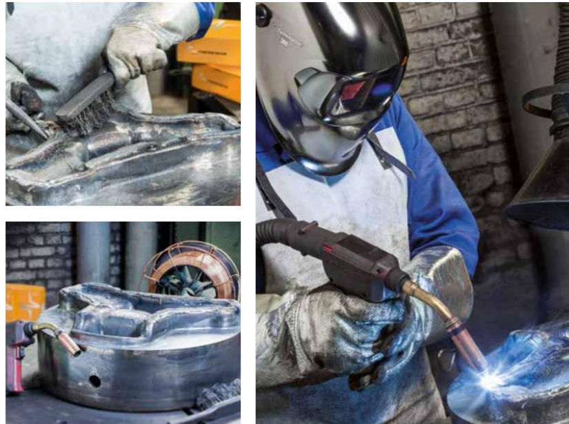
Şekil 2.13. Gazaltı kaynağı ile sert dolgu uygulama örneği (Böhler, 2016b).
