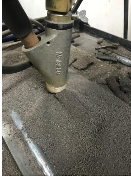
Şekil 2.9. Tozaltı kaynağı uygulaması
