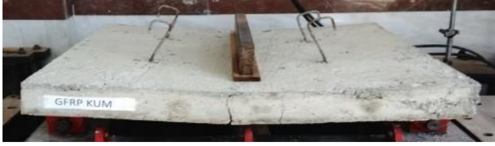
Şekil 4.80. GFRP donatılı döşeme kırılma sonrası
