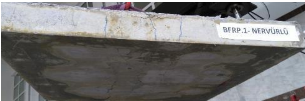
Şekil 4.71. BFRPN donatılı döşeme kırılma detayı
