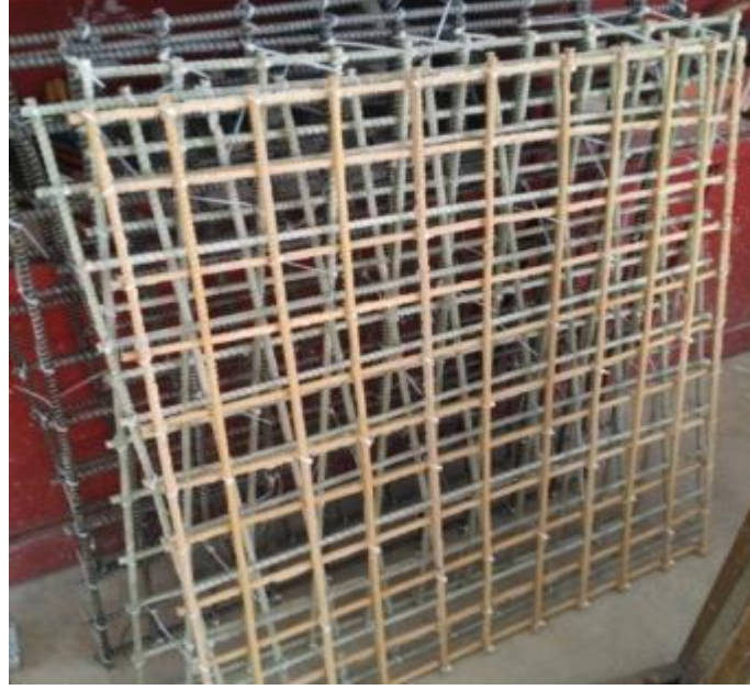
Şekil 4.17. FRP Donatı çubuklarının hazırlanması ve montaj aşaması
