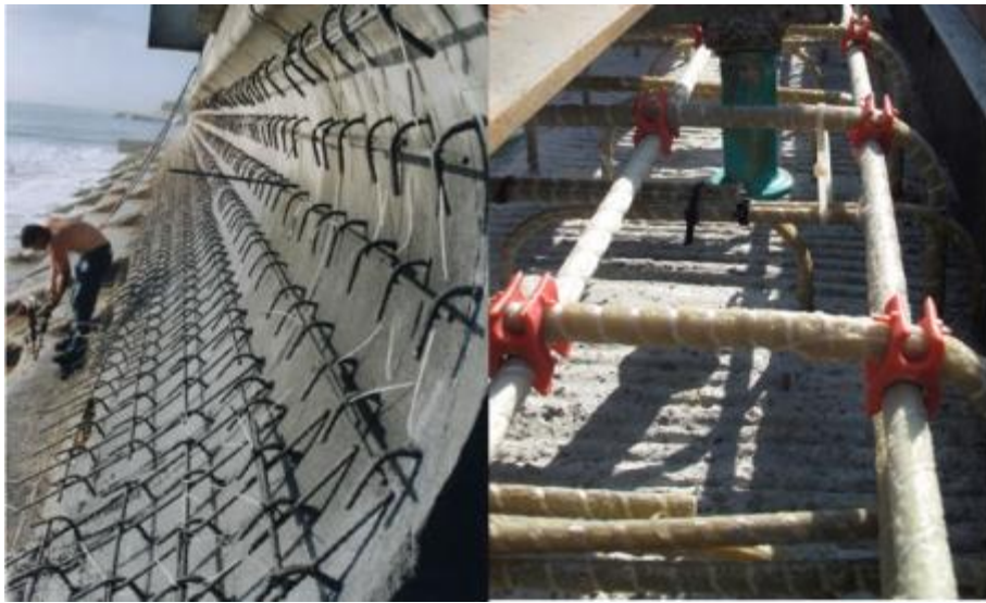
Şekil 3.17. FRP donatıların kıyı yapılarında kullanımı [1].
