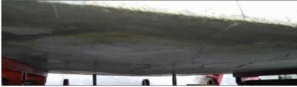
Şekil 4.81. GFRPK donatılı döşeme kırılma detayı
