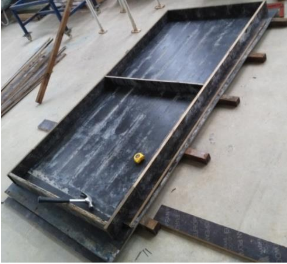
Şekil 4.16. Kalıp sisteminin hazırlanması
