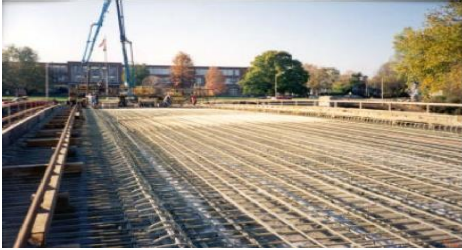
Şekil 3.11. Ohio'da köprü döşemesinde GFRP donatılar [1].
