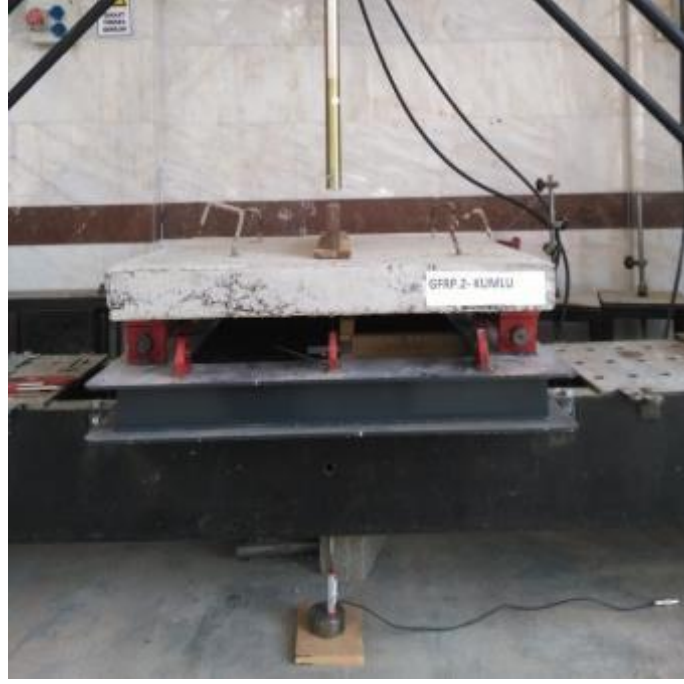
Şekil 4.41. GFRPK donatılı döşeme kırılma öncesi
