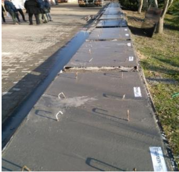
Şekil 4.25. Beton dökme işleminin tamamlanması ve isimlendirilmesi
