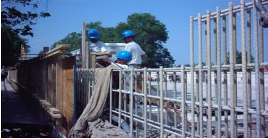
Şekil 3.15. FRP donatıların kıyı yapılarında kullanımı [1].
