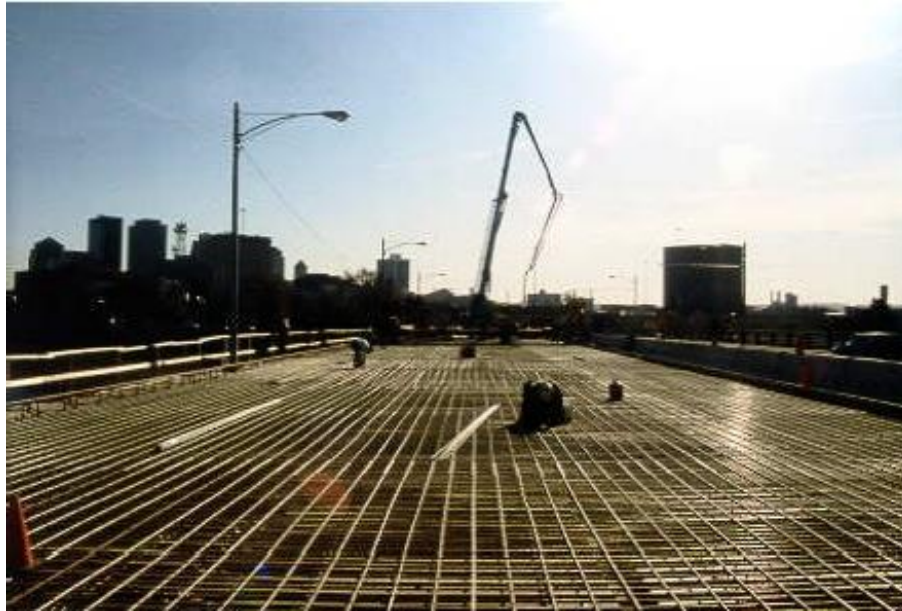
Şekil 3.12. Salem Avenue Köprüsünde GFRP kullanımı [1].
