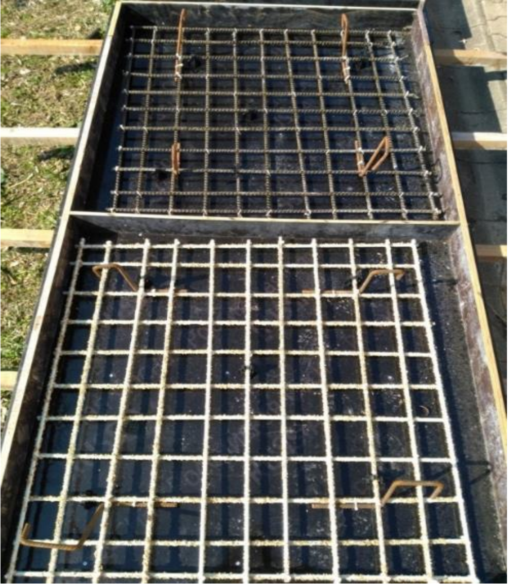
Şekil 4.20. FRP donatıların kalıplara yerleştirilmesi
