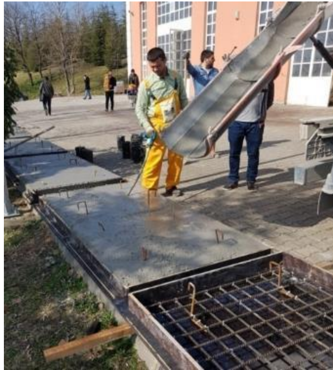
Şekil 4.23. Beton döküm işlemi
