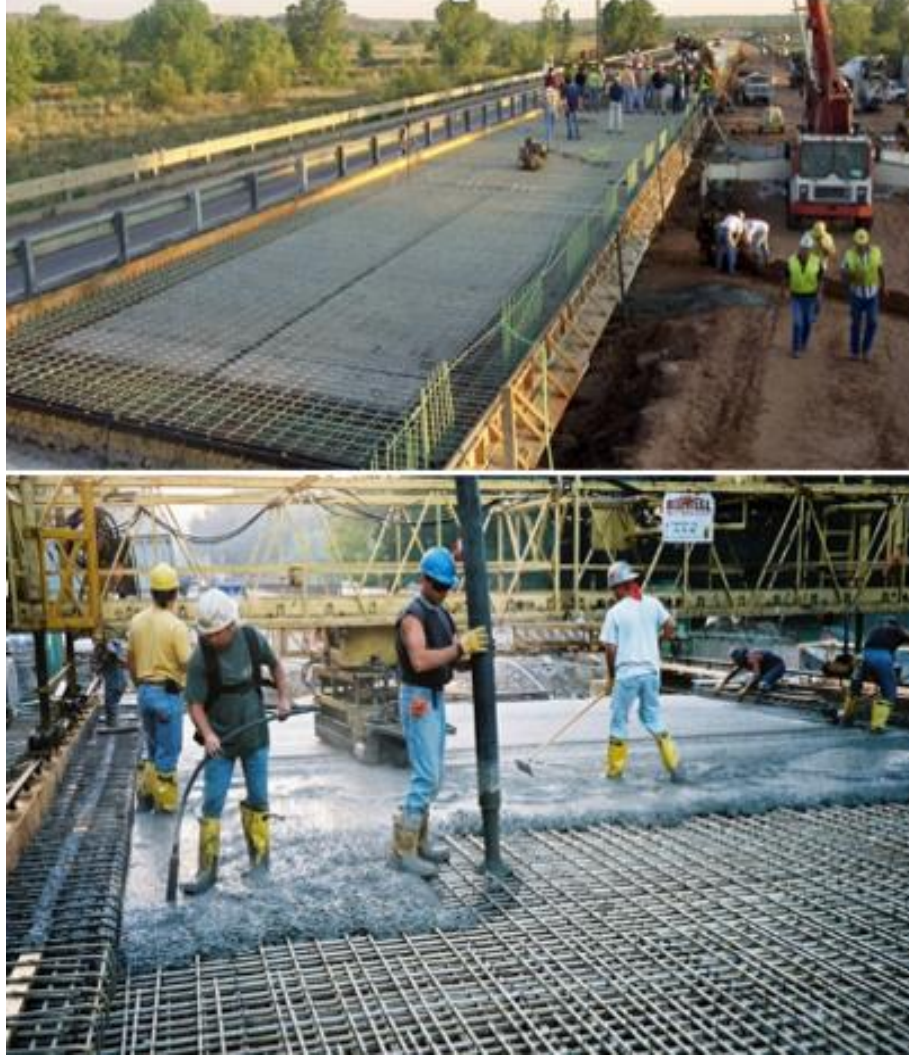
Şekil 3.14. FRP donatıların köprü döşemelerinde kullanımı [1].
