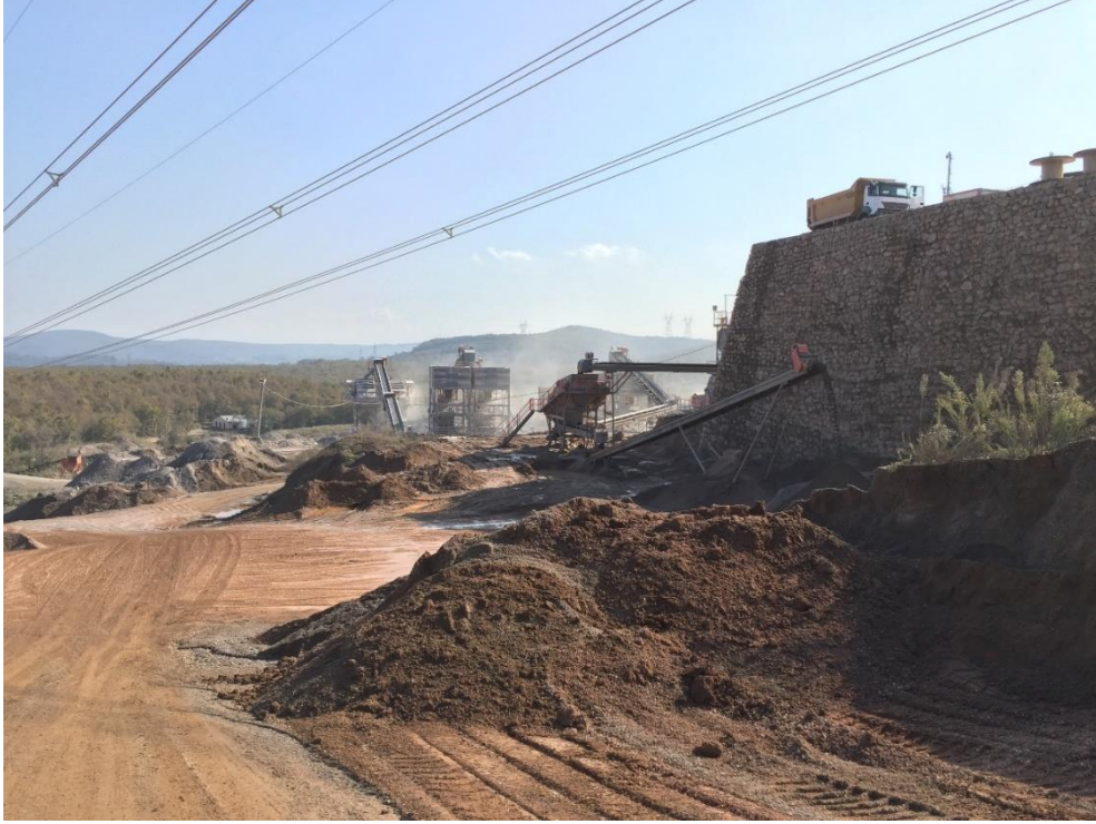
Şekil 2.3. Taş kırma - eleme tesisi.
