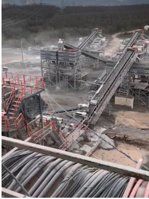
Şekil 3.2. Taş kırma- eleme tesisi
