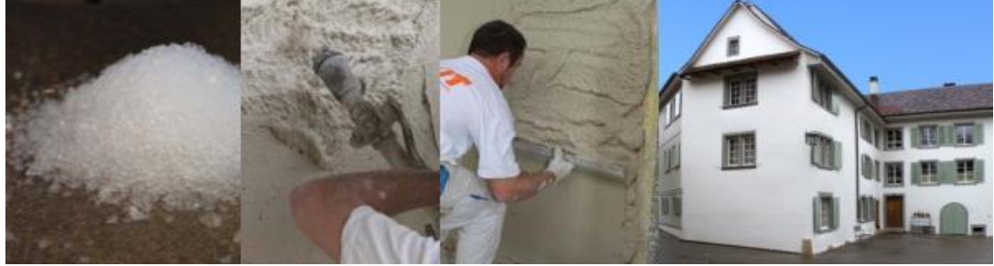
Şekil 3.5. Aerojel granülleri ve granül bazlı sıvanın cephelerde kullanımı [28].
