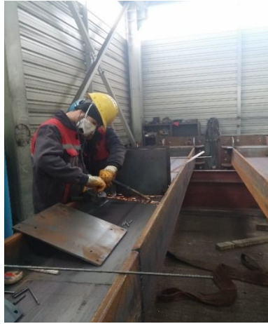
Şekil 3.2. Döşeme mesnet çubuklarının hazırlığı
