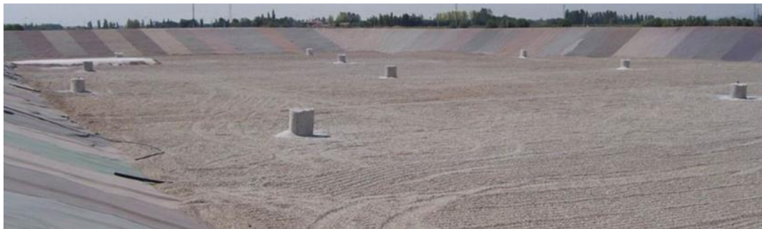
Şekil 5.3. Katı atık depolama sahası taban drenajı tabakası
