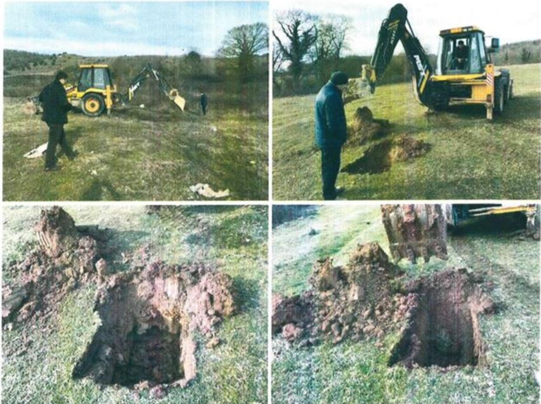
Şekil 6.29. İnceleme alanında yapılan araştırma çukuru kazısı çalışmaları
