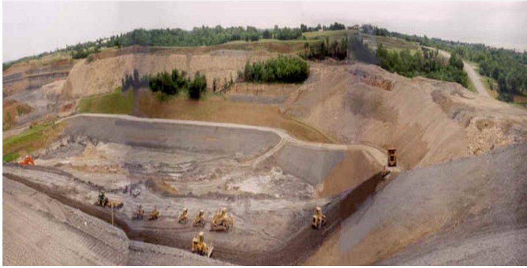
Şekil 1.1. Kontrollü dolgu yapılan katı atık düzenli depolama sahası
