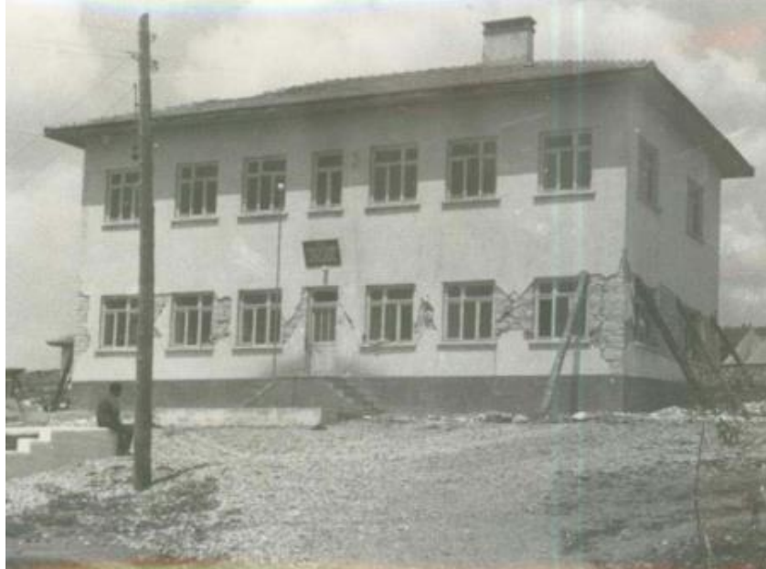
Şekil 2.8. Rijit kat döşemeli yığma yapıda deprem hasarı [33]
