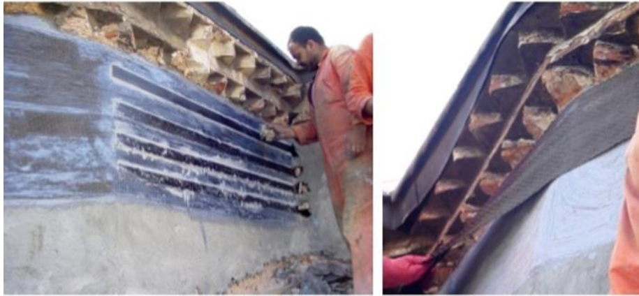
Şekil 2.20. LP kumaş ile güçlendirme [28]
