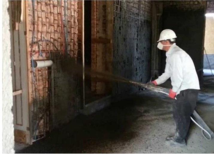
Şekil 2.10. Püskürtme beton uygulaması [35]
