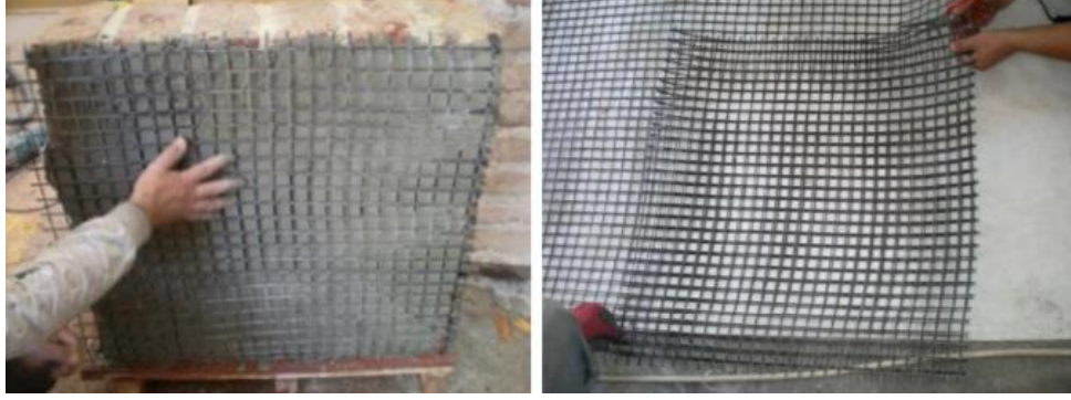
Şekil 2.19. TRM uygulaması ile güçlendirme [36]
