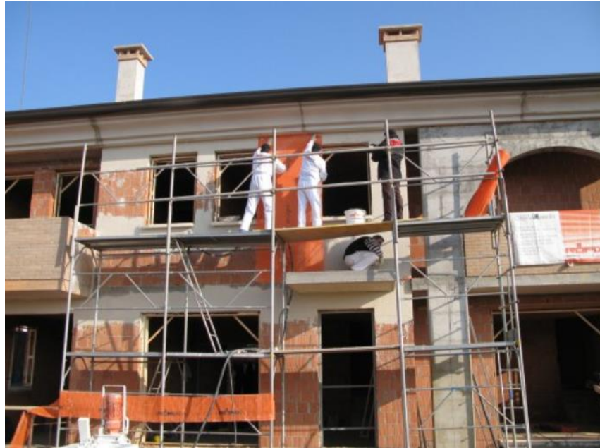
Şekil 2.18. Cam fiber kaplama ile güçlendirme
