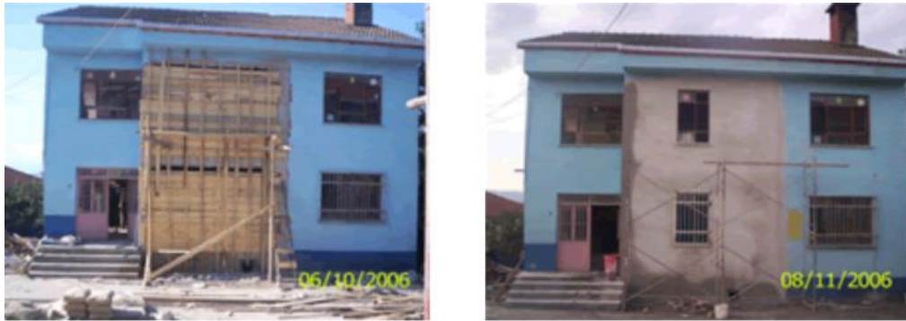
Şekil 2.13. Kendiliğinden yerleşen beton uygulaması ile güçlendirme [27]
