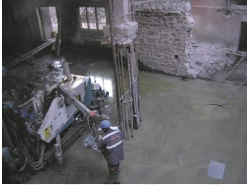
Şekil 2.14. Yığıma yapı temel güçlendirmesi [28]
