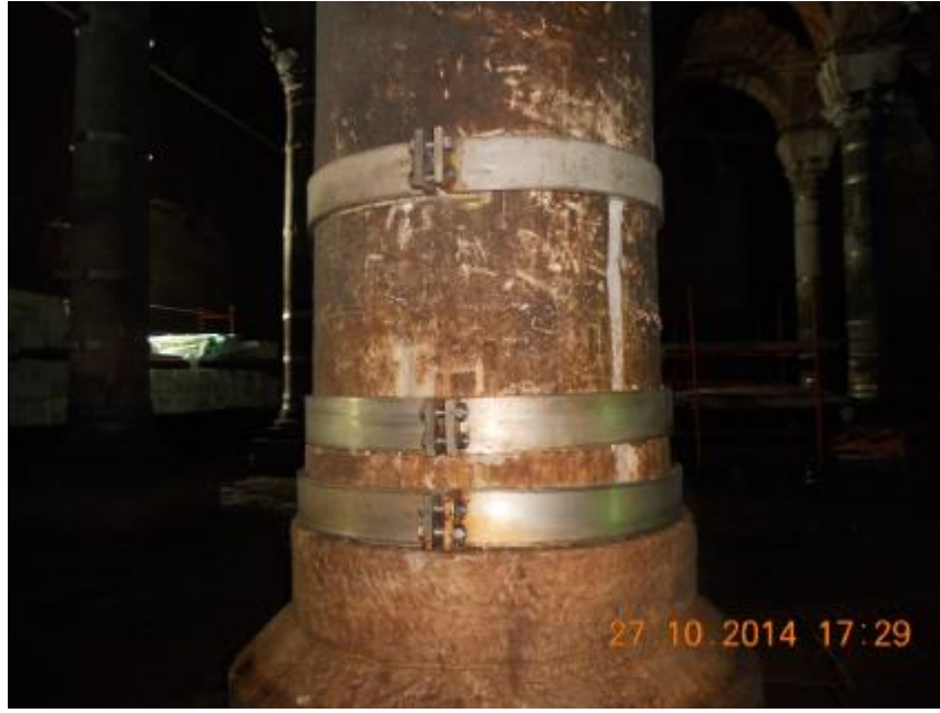
Şekil 2.12. Sütun elemanların çelik çemberler ile güçlendirilmesi [28]
