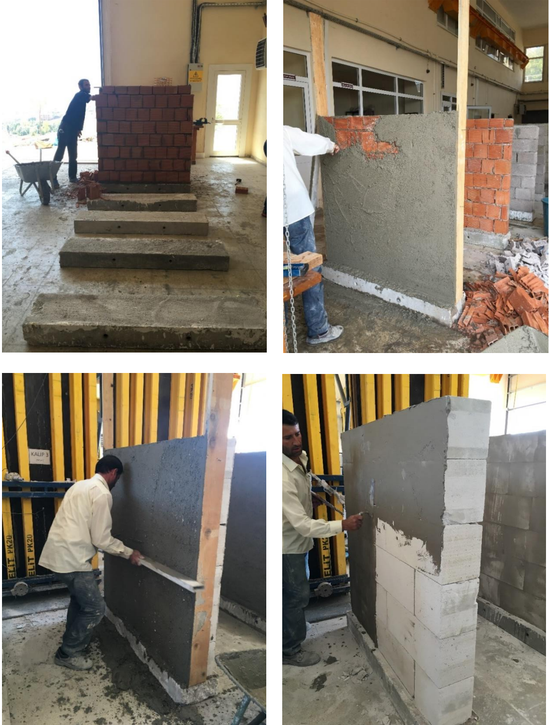
Şekil 3.4. Dolgu duvarların örülmesi ve sıvanması
