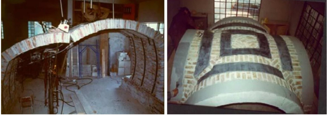
Şekil 2.4. a) FRP ile kemer güçlendirilmesi
