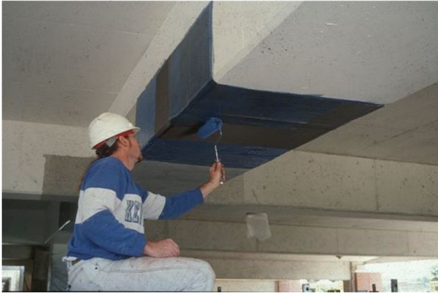
Şekil 2.4. b) FRP ile kiriş elemanının güçlendirilmesi
