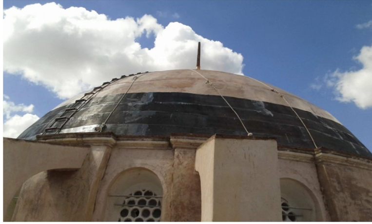
Şekil 2.4. e) FRP ile kubbe güçlendirilmesi
