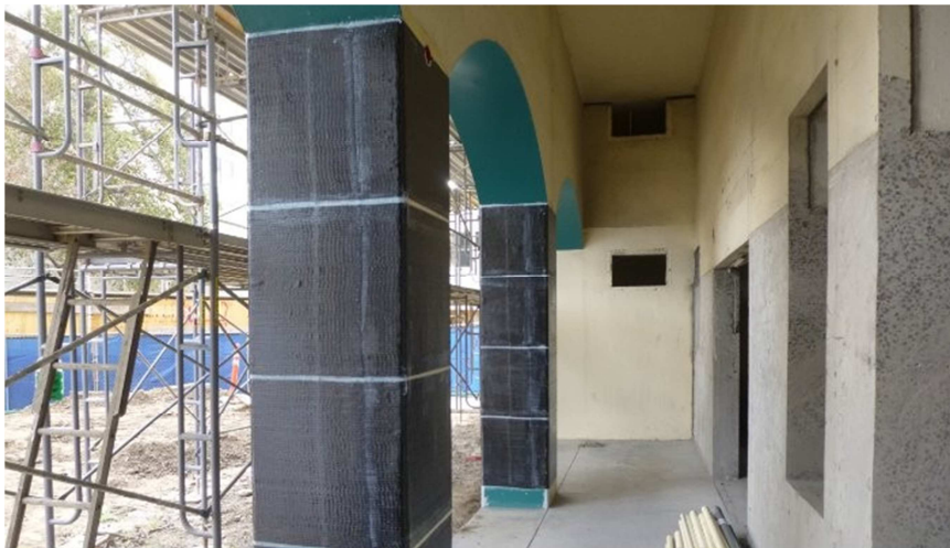
Şekil 2.4. c) FRP ile kolon elemanının güçlendirilmesi
