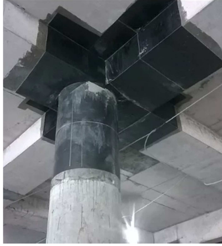
Şekil 2.4. d) FRP ile kolon-kiriş birleşimlerinin güçlendirilmesi
