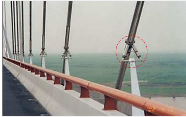
Şekil 2.14. The Dong Ting Lake'deki taşıyıcı kablolara MR damper uygulaması [31].
