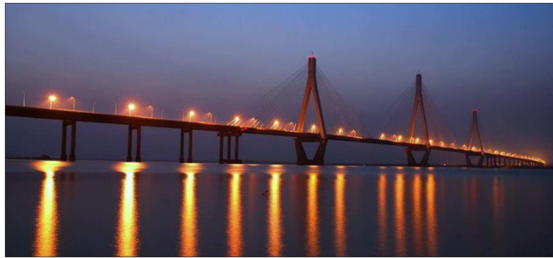
Şekil 2.13. The Dongting Lake Köprüsü, Çin [31].
