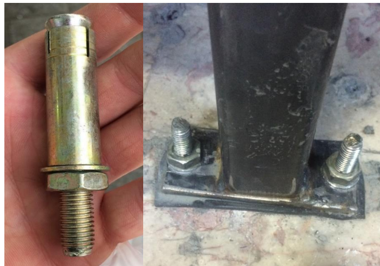
Şekil 4.13. a) metrik 6 vida yerine kullanılan metrik 10 vidalar b) ayakların sabitlendiği metrik 10 vidalar
