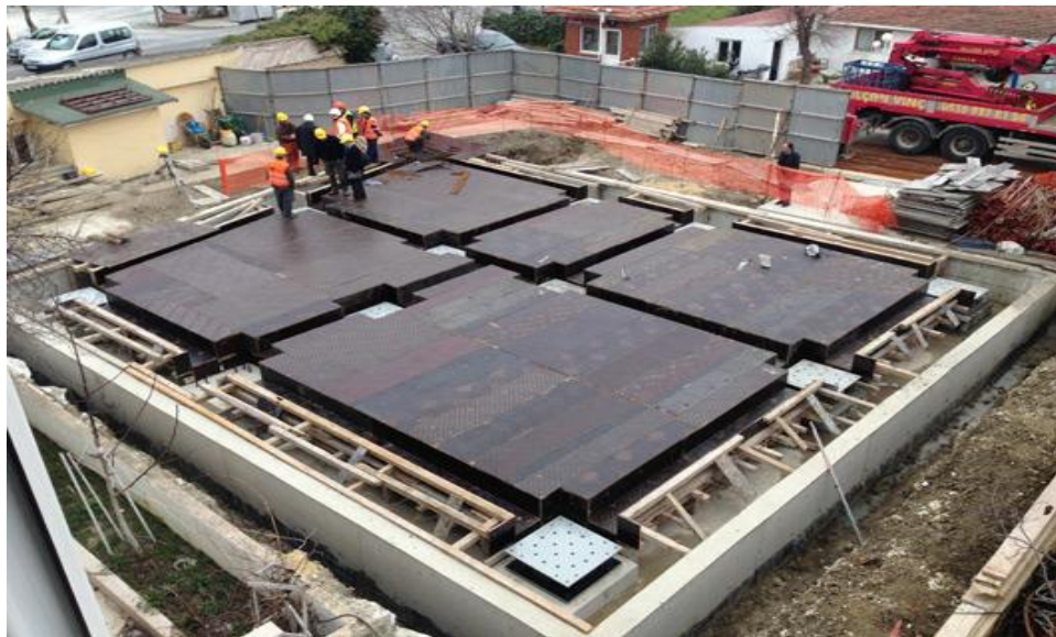
Şekil 2.12. Türkiye'nin İlk Sismik İzolatörlü Konut Binası ( Aykent Loft Projesi)
