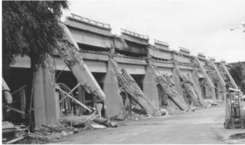
Şekil 2.14. 1989 Loma Prieta depreminde Cypress caddesi viyadüğünün çöküşü
