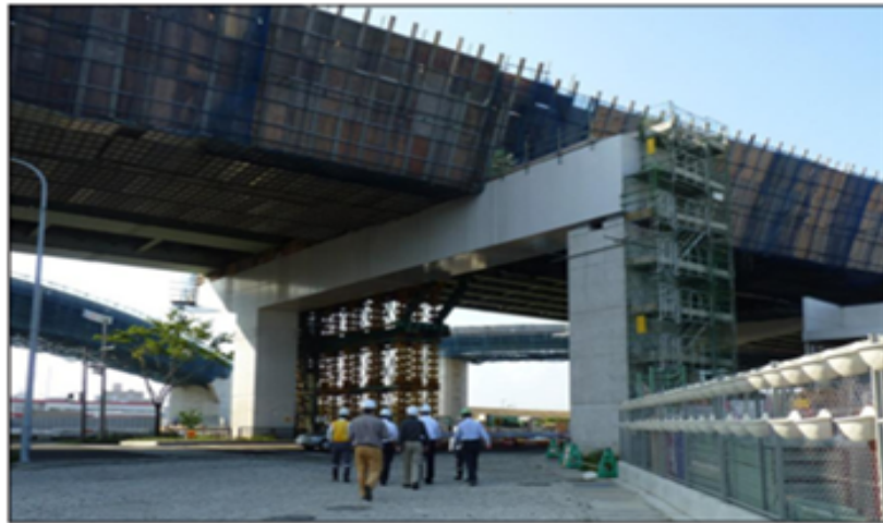
Şekil 2.21. İki kolonlu çerçeve köprü ayağı, Sendai-Tobu viyadüğü
