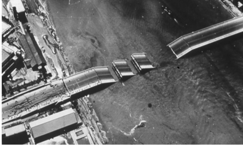
Şekil 2.16. 1964 Niigata depreminde Showa köprü çöküşü [37]
