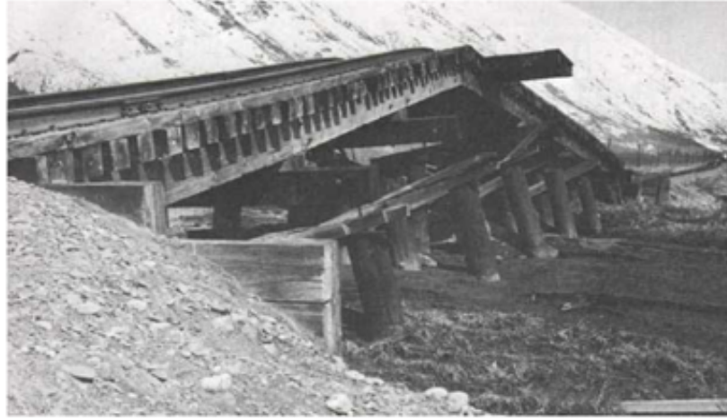
Şekil 2.20. Yanal yayılma nedeniyle kazık ayağın dikey bükülmesi [42]
