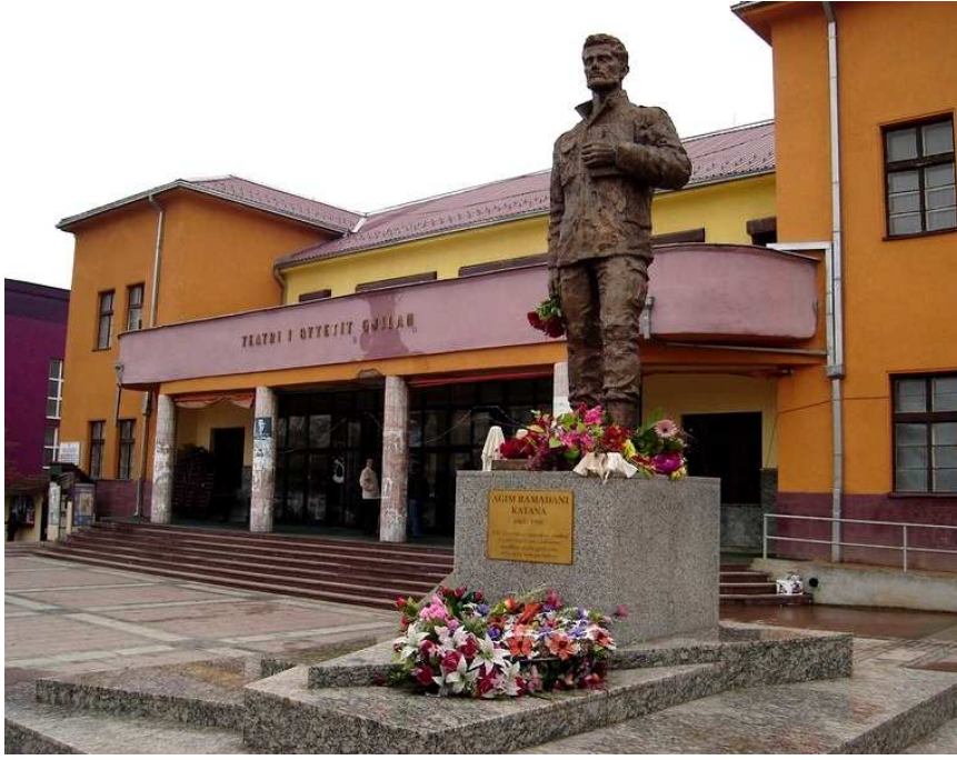
Fotoğraf 3. Gilan tiyatrosu binası
