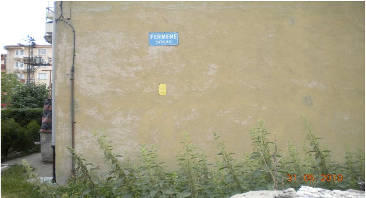
Resim 48. Yıldırım Bayezid Mahallesi Fermene Sokak
