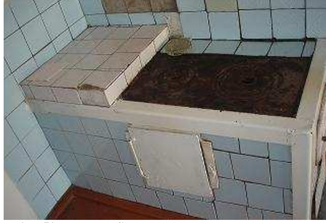
Resim 52. Taş Ev Sobası: Kışın ısınmak için taştan ve demirden yapılmış sobalar kullanılmaktadır. Bir defa yakıldığında evin bütün odalarını ısıtmaktadır. Genelde yakmak için tezek kullanılmaktadır.
