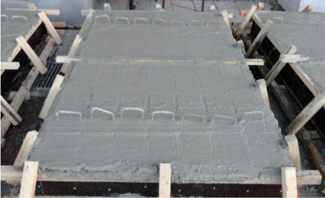
b) Betonun tesviye edilmiş hali
