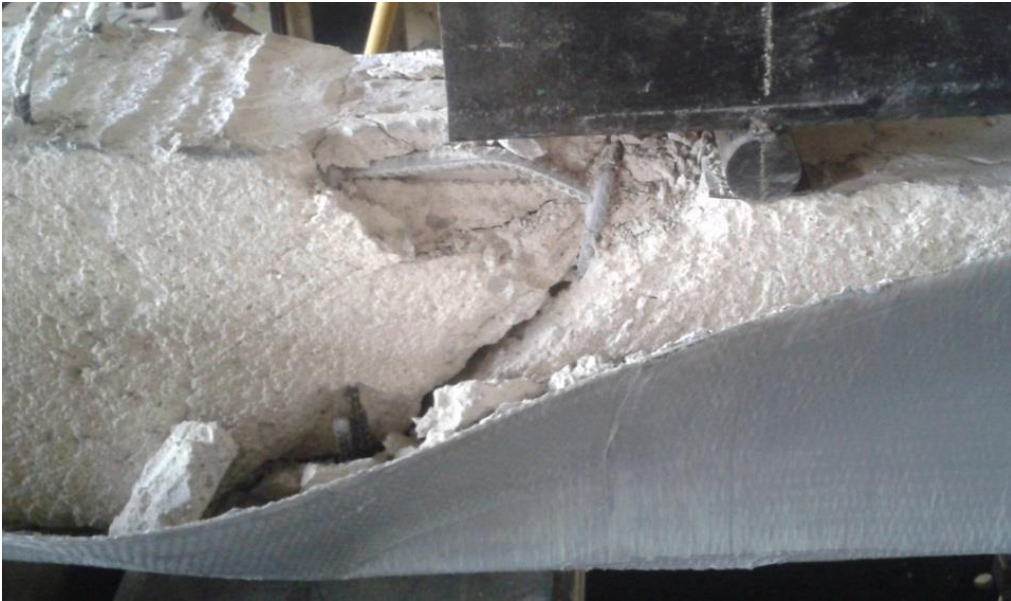
Şekil 5.17. Yükleme sonrası GFRP22 kirişi deformasyonlar
