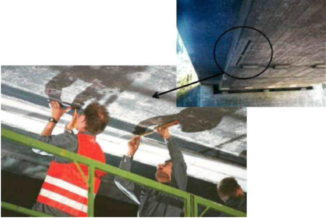
Şekil 1.2. Ibach Köprüsü CFRP plaka uygulaması
