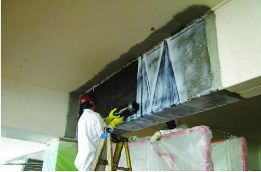
Şekil 1.6. FRP malzemenin kirişlerde uygulanması
