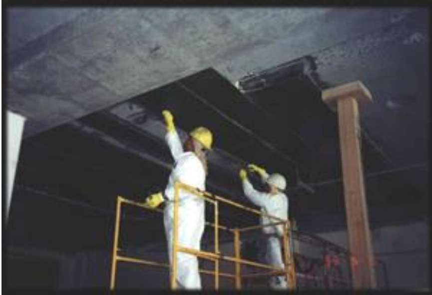
Şekil 1.8. FRP malzemenin döşemelerde uygulanması
