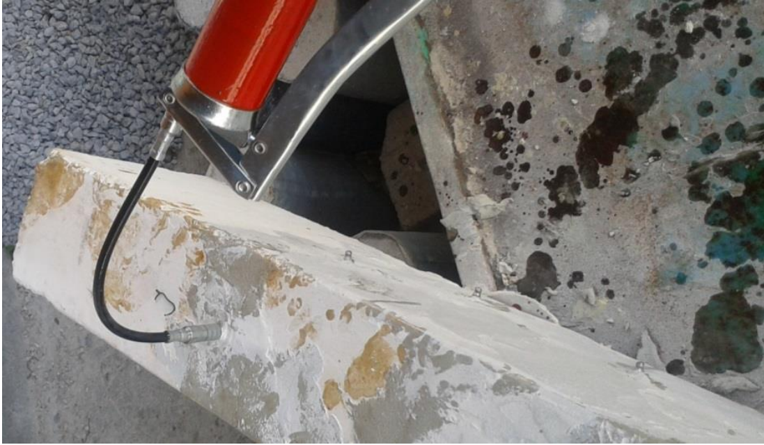
Şekil 3.16. Kiriş çatlaklarının enjeksiyon reçinesi ile onarılması
