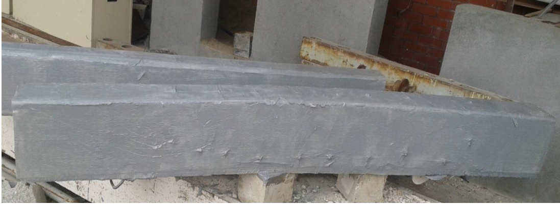
Şekil 3.17. Onarım ve güçlendirilmesi tamamlanan GFRP2-O/G kirişleri
