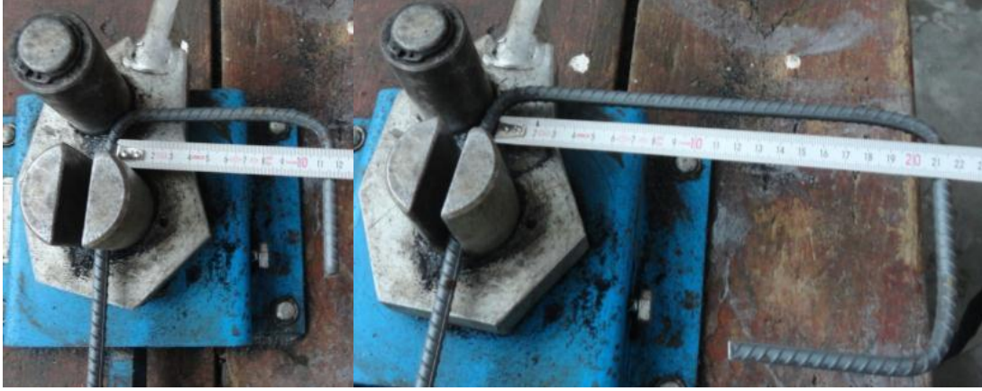
Şekil 3.6. Enine donatıların hazırlanması
