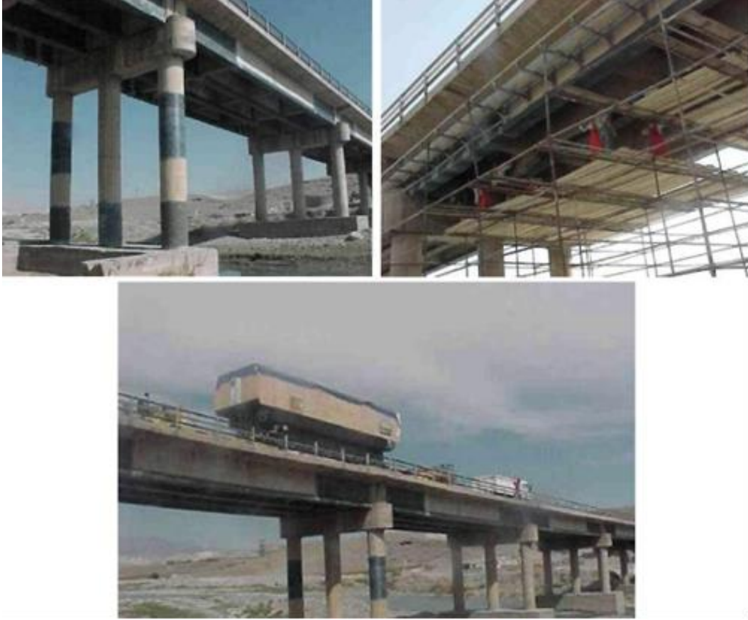
Şekil 1.3. Göksu Köprüsü güçlendirme çalışması
