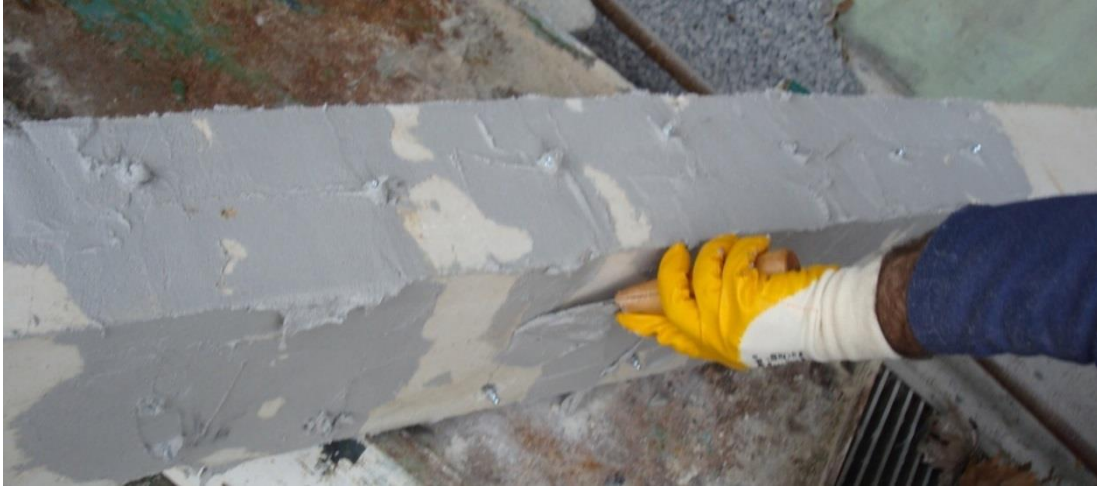
Şekil 3.15. Kiriş çatlaklarının tamir harcı ile kapatılması
