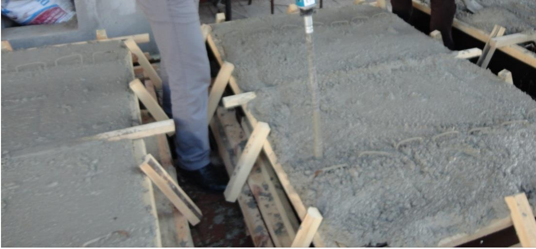
a) Betonun dökümü ve yerleştirilmesi
