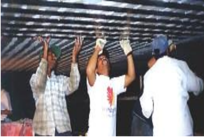
Şekil 1.9. FRP malzemenin döşemelerde uygulanması
