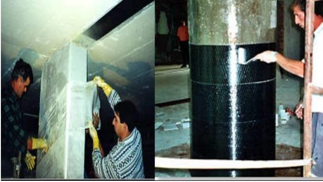
Şekil 1.4. FRP malzemenin kolonlarda uygulanması
