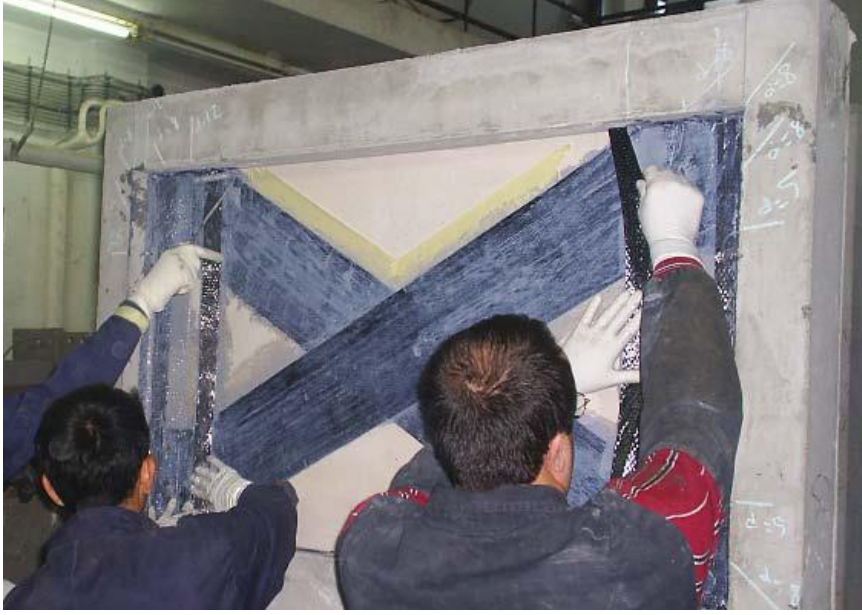
Şekil 1.10. FRP malzemenin dolgu duvarlara uygulanması
