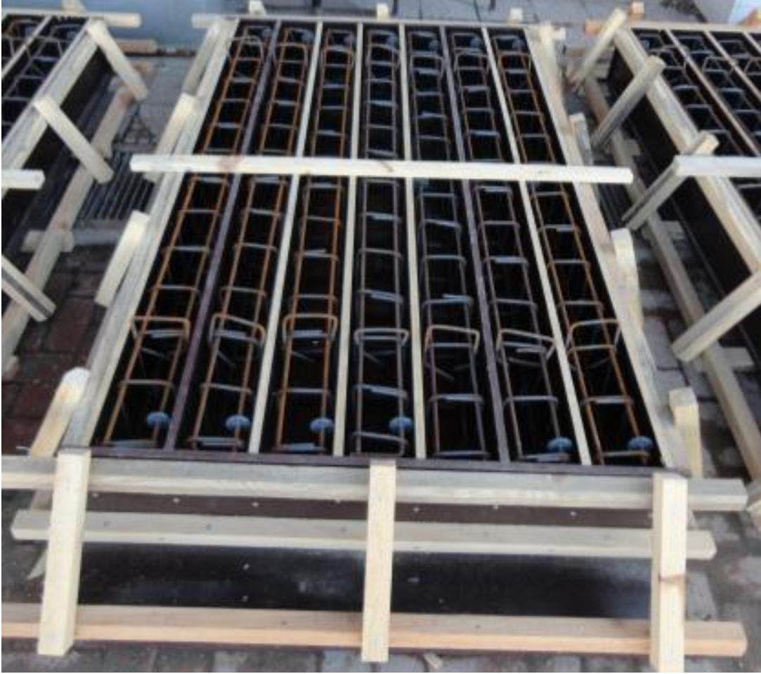
Şekil 3.8. Çelik donatısı yerleştirilen kiriş kalıbı
