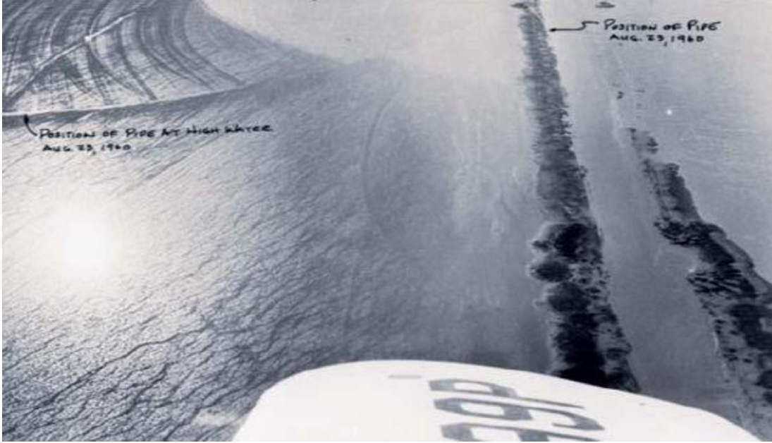
Şekil 2.8. Çamurlu yüzeyde yüzen iki boru hattının havadan görünüşü [36]
