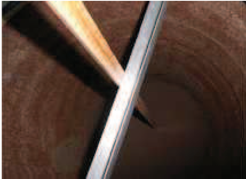
Şekil 4.12. Tamamlanan tabaka için kot kontrolü
