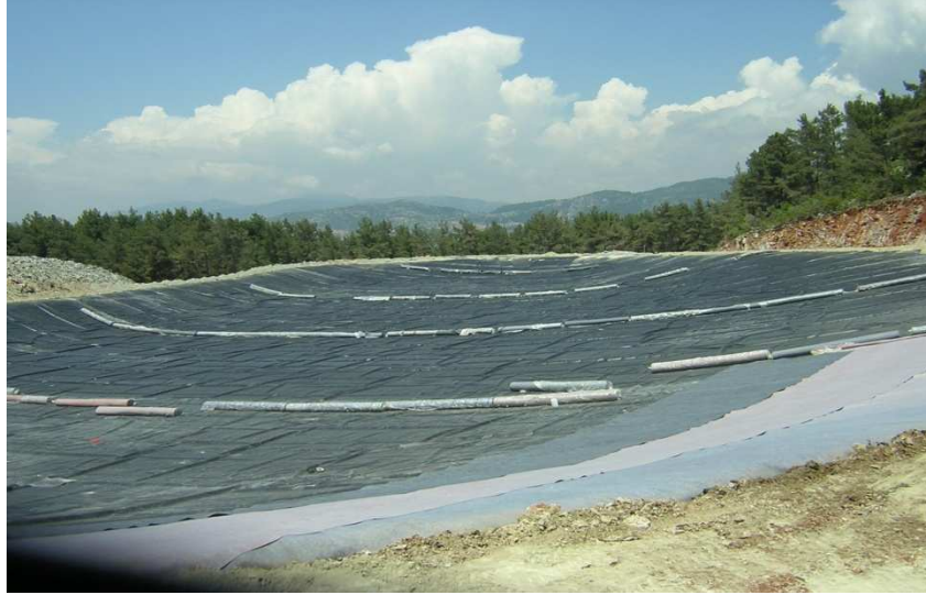
Şekil 2.3. Geomembran Serilmesi
