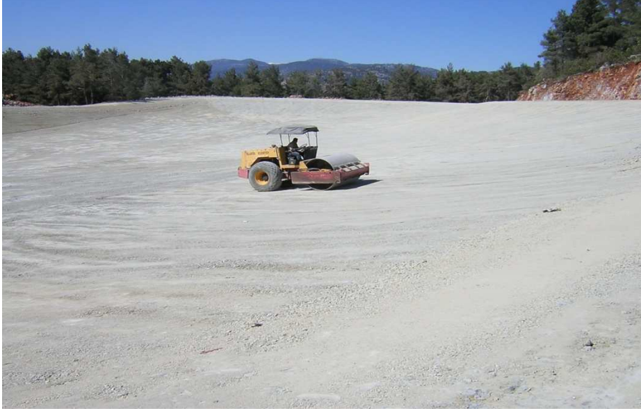
Şekil 2.2. Kil Geçirimsizlik Tabakasının Sıkıştırılması İşlemi
