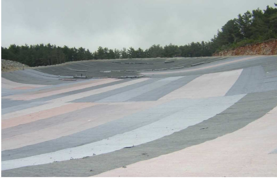
Şekil 2.4. Geotekstil Serilmesi
