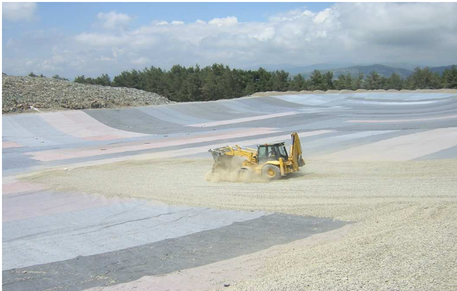
Şekil 2.5. Drenaj İçin Filtre Çakılı Serilmesi
