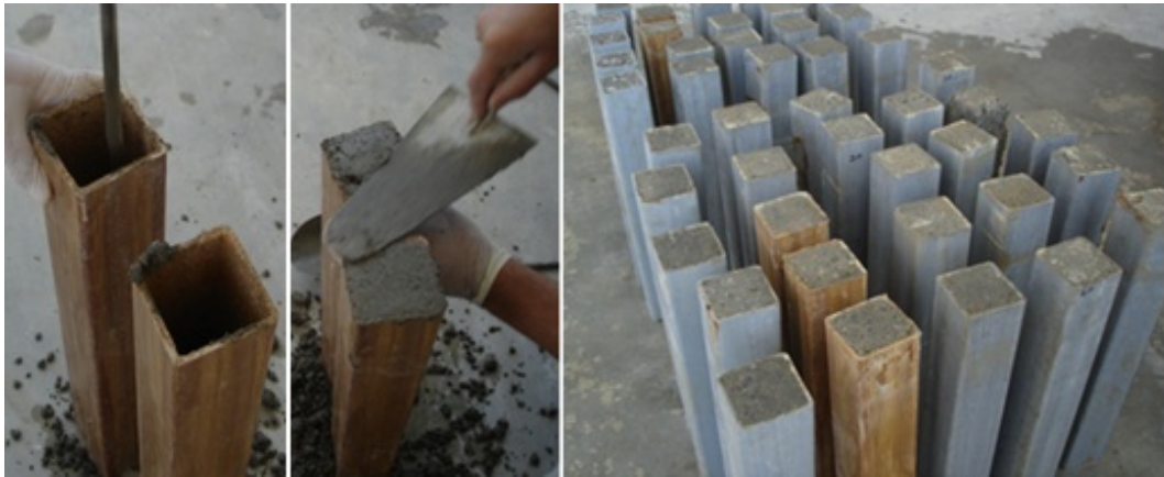
Şekil 3.23. GFRP profillerin taze beton ile doldurulması
