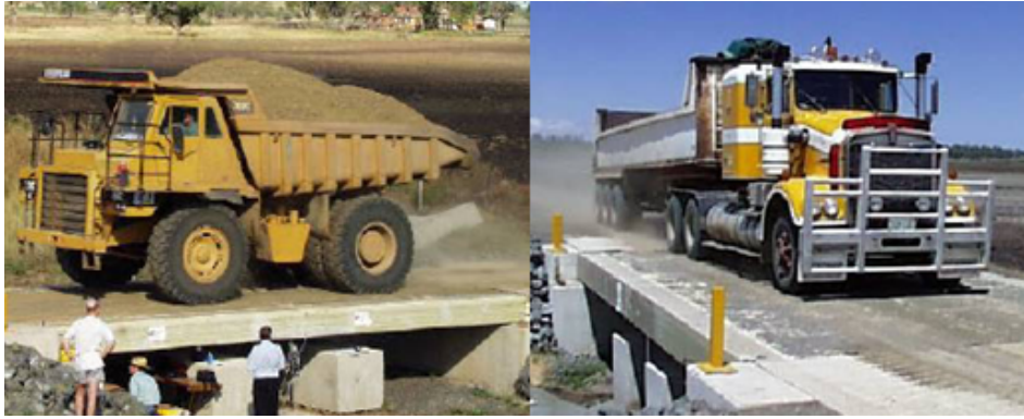
Şekil 2.17. GFRP kirişler ve beton ile imal edilmiş ağır taşıt köprüsü [57]
