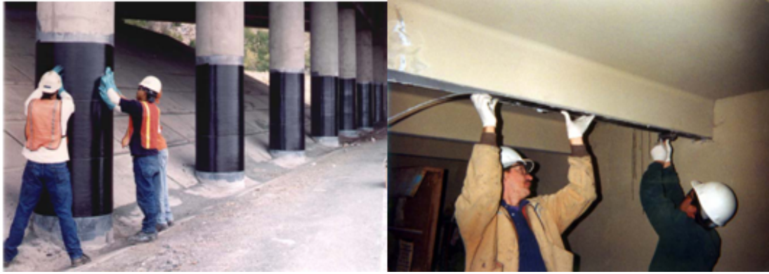
Şekil 1.3. Betonarme kolon ve kirişlerin FRP'ler ile güçlendirilmesi
