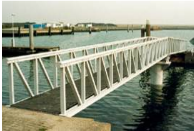
Şekil 2.9. GFRP vapur iskelesi [47]
