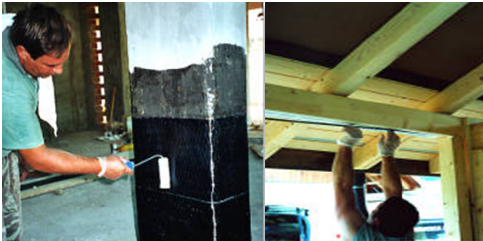
Şekil 2.8. FRP ile betonarme ve ahşap yapı güçlendirilmesi
