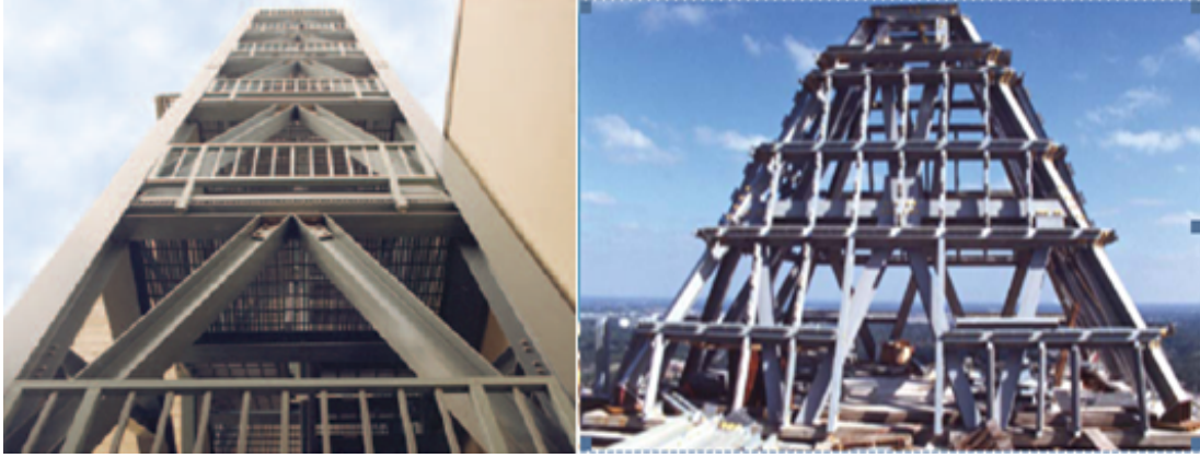
Şekil 2.12. GFRP profillerden imal edilmiş kuleler [44]
