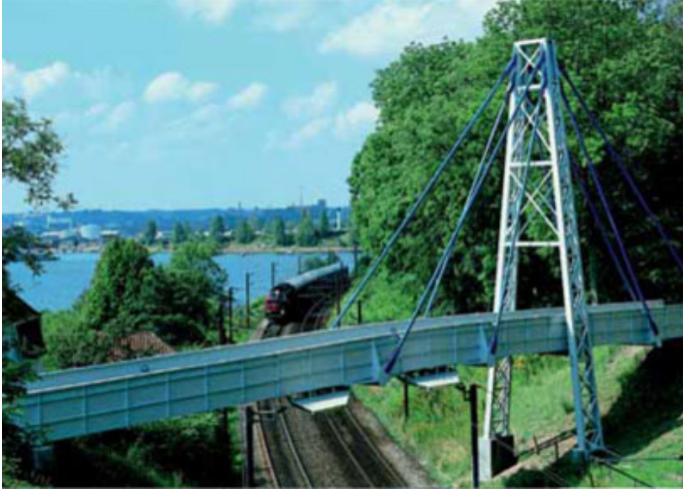
Şekil 1.2. GFRP yaya ve hafif araç köprüsü [5]
