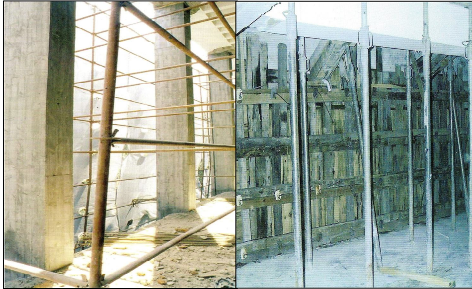
Şekil 2.2. KYB ile betonarme manto uygulamaları
