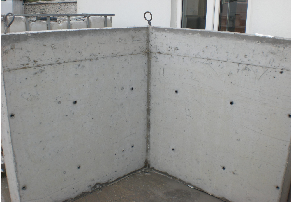
Şekil 3.16. Kalıbından sökülen ve karot alımına hazır halde bulunan perde elemanı
