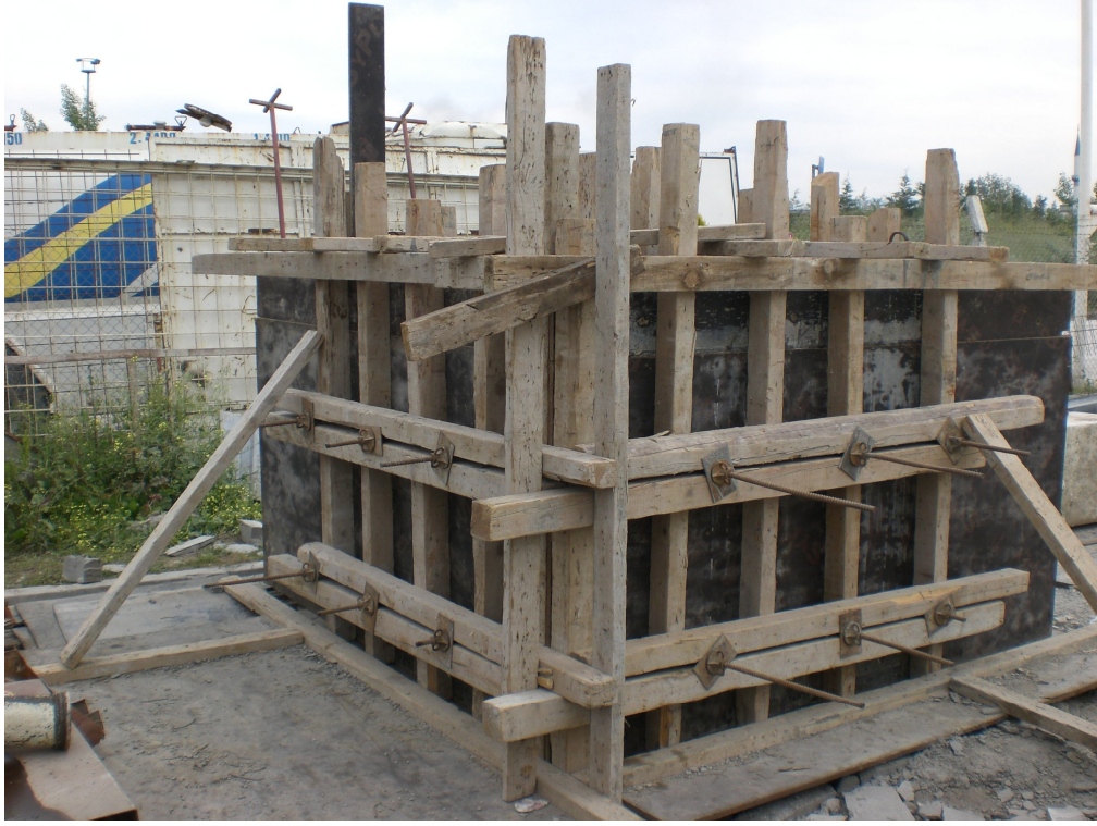
Şekil 3.15. Perde elemanlarına beton dökümü için hazırlanan kalıp
