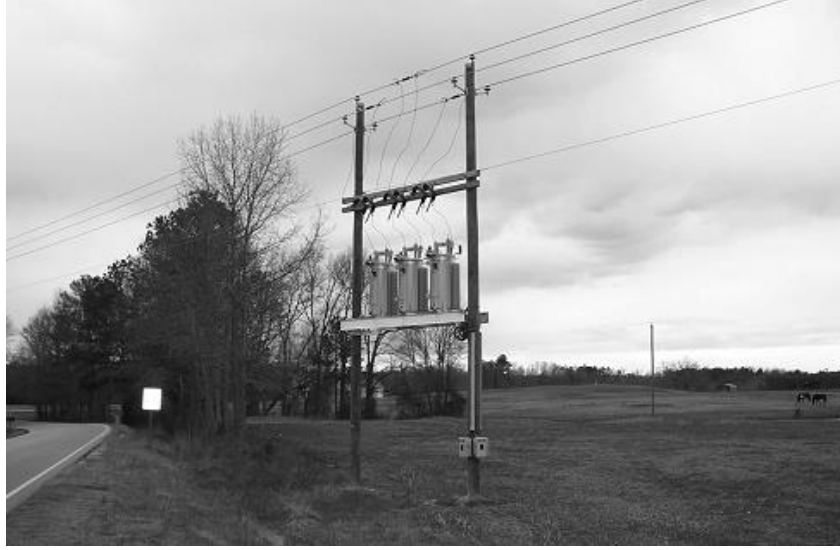
Şekil 3.7. Dağıtım fideri üzerinde bulunan üç tek fazlı gerilim regülatörü [87].
