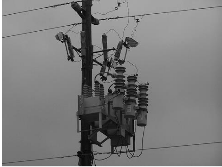
Şekil 3.13. Dağıtım fideri üzerinde bulunan direk tepesi anahtarlamalı kondansatör bankası [87].
