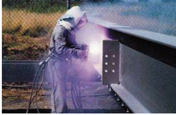
Şekil 3.11. Köprü konstrüksiyonunun korozyona karşı kaplanması [35].
