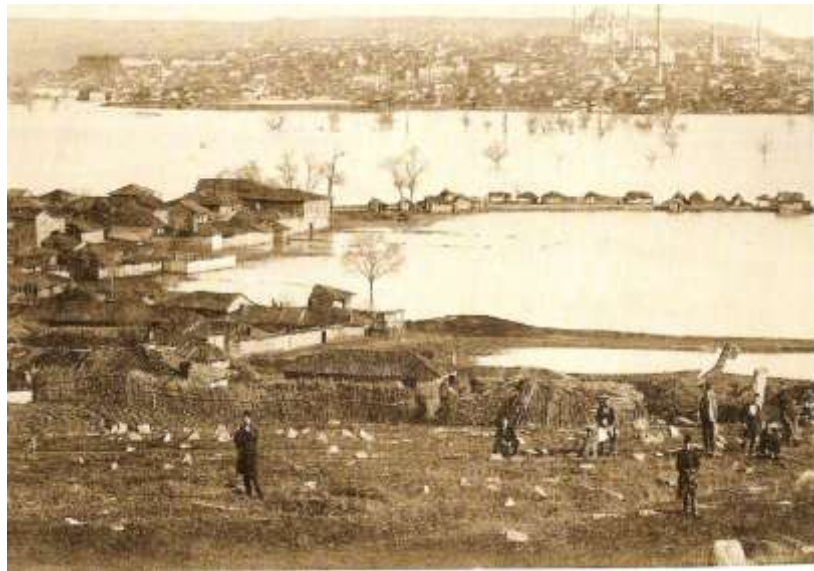
Şekil 3.6. Tunca Vadisi taşkın suları altında [78].
