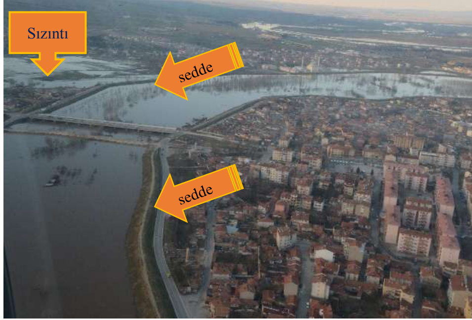
Şekil 5.41. 2015 taşkınında seddeler ve mevcut sedde sızıntıları [23].
