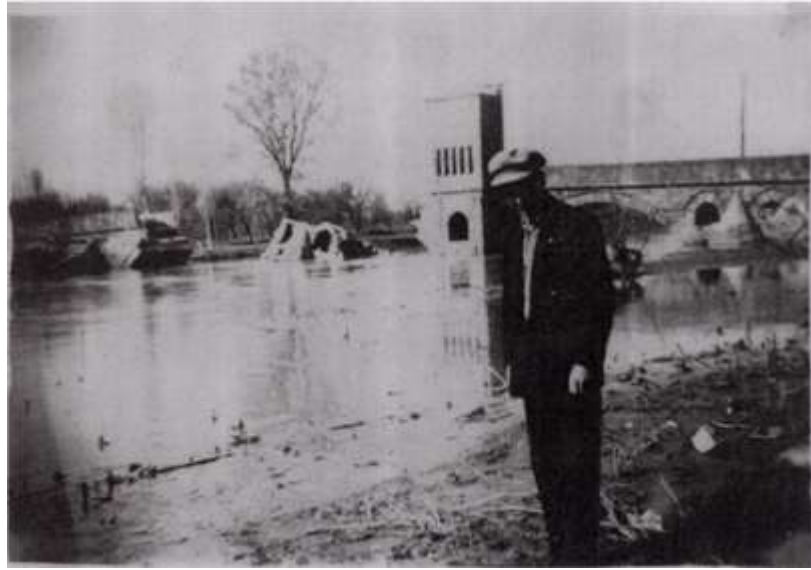
Şekil 3.8. 15 Şubat 1947 taşkının Tunca Köprüsü'nün yıkılmış görüntüsü [71].
