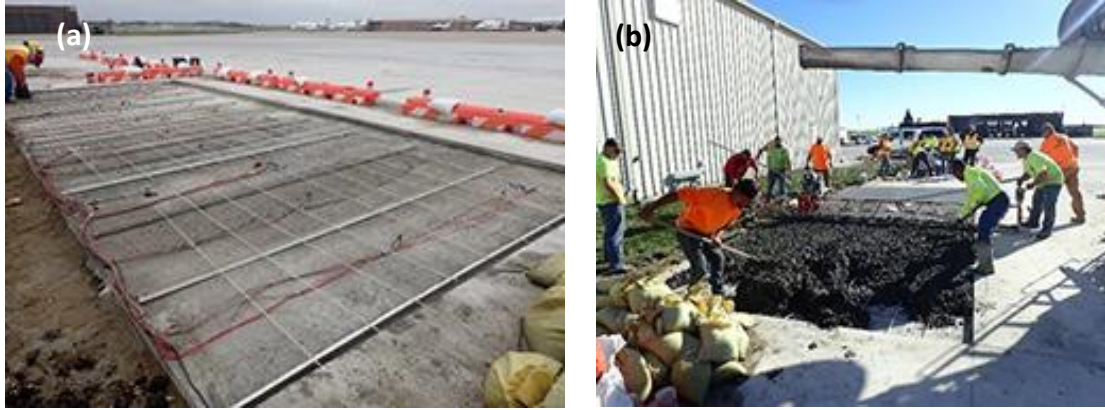
Şekil 1.3. İlk beton tabakası üzerine elektrot yerleştirilmesi ve güç kaynak kablolarına bağlantıları (a) ve elektrik ileten betonun dökülmesi (b) [1].
