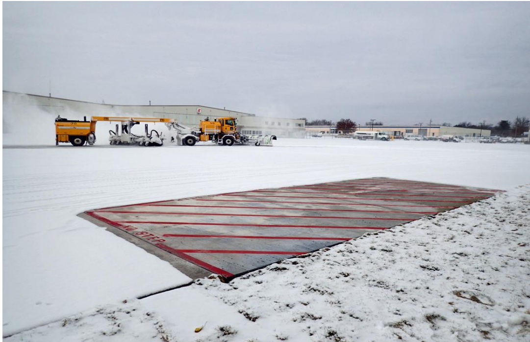
Şekil 1.4. Des Moines uluslararası havaalanında uygulanan elektrik ileten beton plakaların son hali [1].
