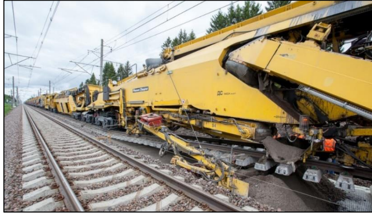
Şekil 4.11. Ray dışında tüm üstyapı bileşenlerinin yenilenmesi (RZD, 2018).
