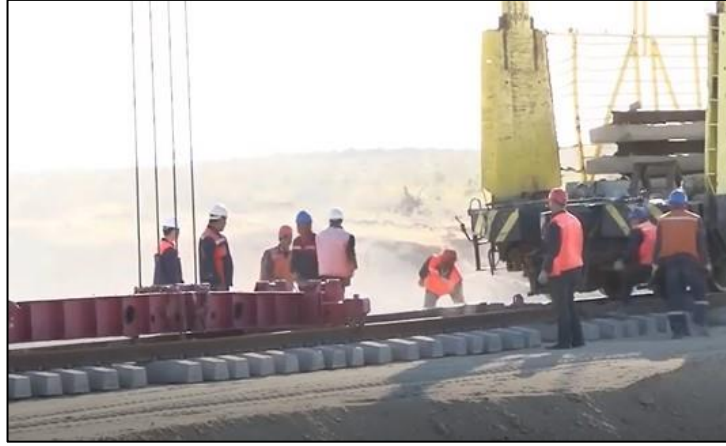
Şekil 4.7. Ray, travers ve bağlantı malzemelerinin yenilenmesi (UTY, 2018).
