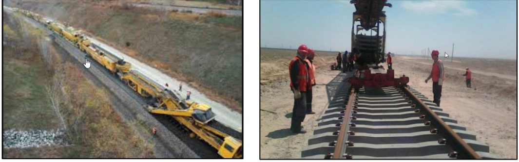
Şekil 4.3. Demiryolu hat yenileme makineleri (RZD, 2018).
