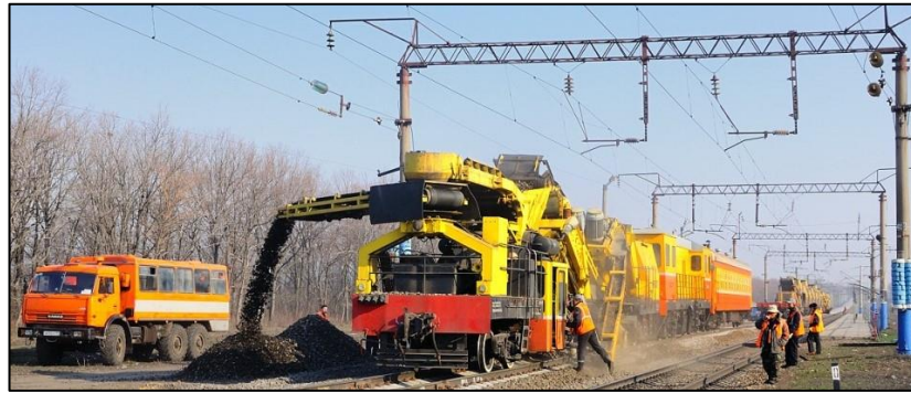
Şekil 4.8. Balast tabakası yenilenmesi (Arteks, 2018).
