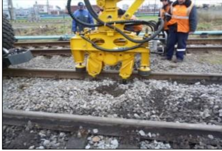
Şekil 4.12. Buraj balast tabakasının sıkıştırılması (RZD, 2018).
