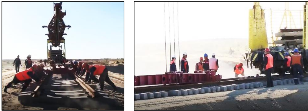
Şekil 5.19. Kızılqum malzemesi üzerine serilen demiryolu hattı (UTY, 2018).
