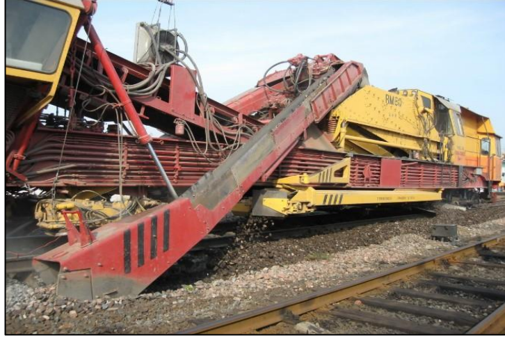
Şekil 4.9. Balast tabakası elemesi (RZD, 2018).
