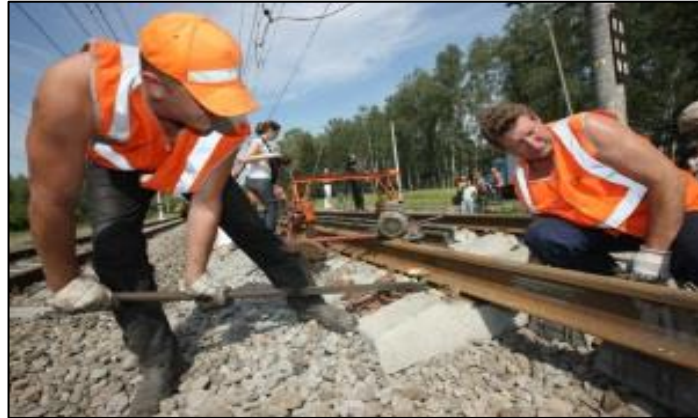
Şekil 4.6. Travers ve bağlantı malzemelerinin yenilenmesi (Transway, 2018).
